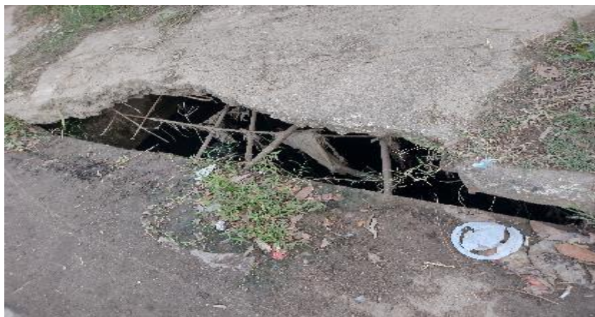
Figura 7 - Ligações irregulares em rede adutora destinada ao polo industrial. Fonte: Arquivo pessoal (2021).
