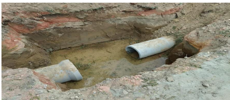
Figura 11 - Obras de drenagem no bairro de Campos Elíseos. Fonte: Registro de morador (em novembro de 2021).
