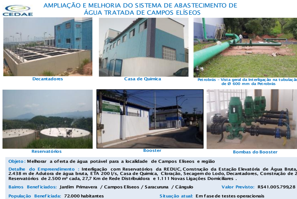
Figura 9 - Ampliação e Melhoria do Sistema de Abastecimento de Água tratada de Campos Elíseos.
