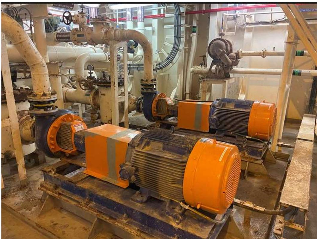
Figura 5.12 – Bombas centrífugas de transferência de fluidos do tanque reserva para o tanque ativo. Fonte: Petrobrás (2024)
