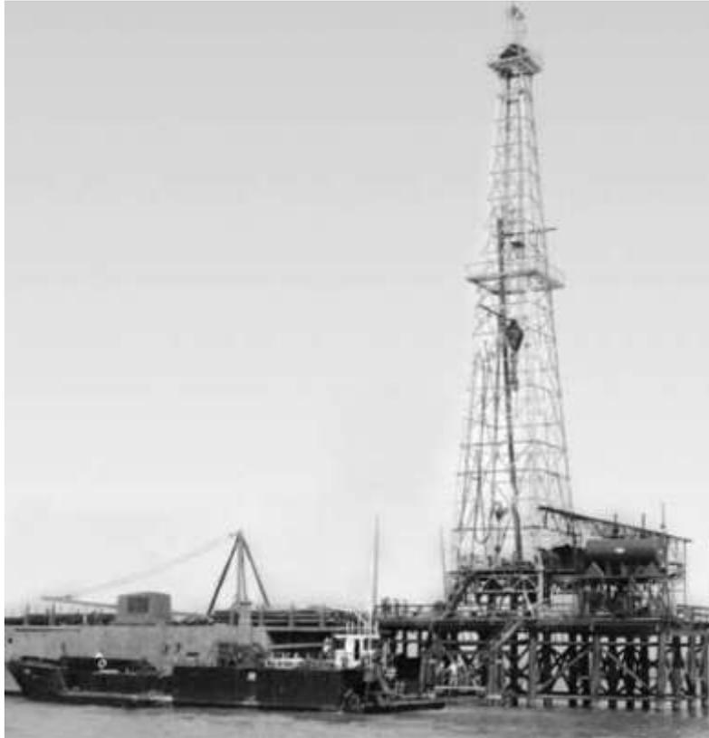
Figura 5.2 – Primeira Sonda de Perfuração offshore fixa. Fonte: Senra, 2013.
