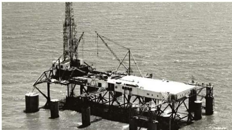
Figura 5.3 – Primeira sonda móvel *offshore*. Fonte: <https://aoghs.org/offshore-oil-history/>. Acesso em: 19 de jul. 2023.
