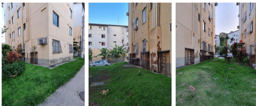
Figura 26 – Imagens do Condomínio Ismael Silva – conservação dos blocos e instalações de gás
