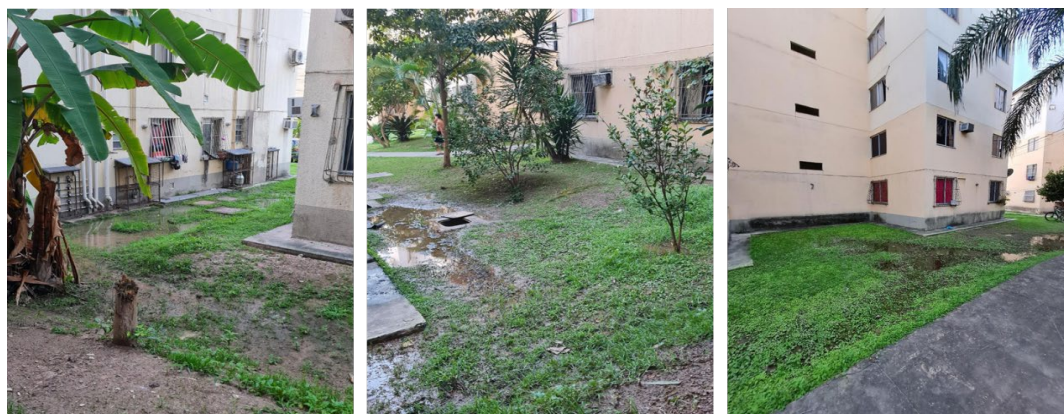
Figura 30 – Imagens do Condomínio Ismael Silva - drenagem Fonte: Acervo de imagens da autora
