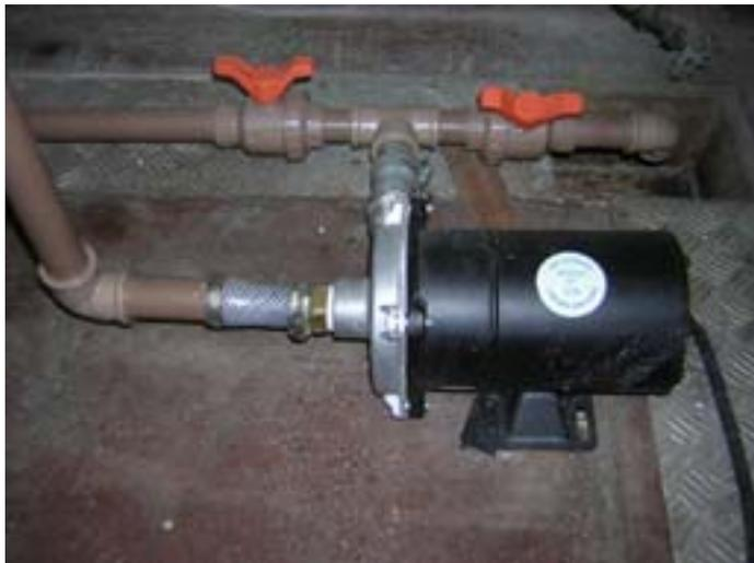
**Figura 4** – Bomba trifásica rotativa de 1/2cv *CAM-W4-NE*.
