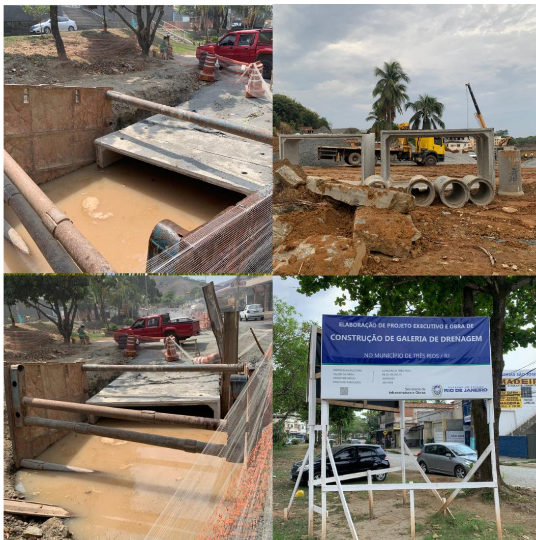
Figura 43 - Obra de ampliação de galeria subterrânea no bairro Triângulo, Três Rios, RJ. Fonte: Acervo pessoal do autor.
