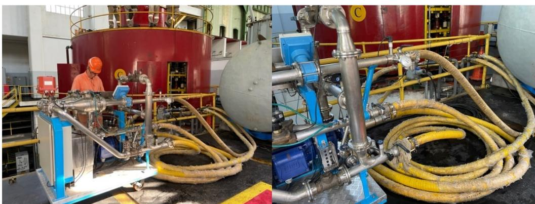
Figura 13 - Acoplamento do *OnlineCleaner* ao trocador de calor
