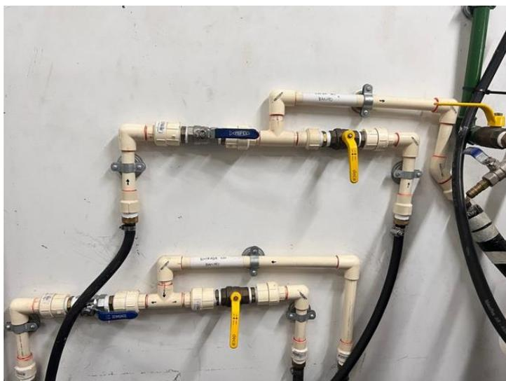
Figura 11: Configuração da manobra de válvulas dos circuladores de banho
