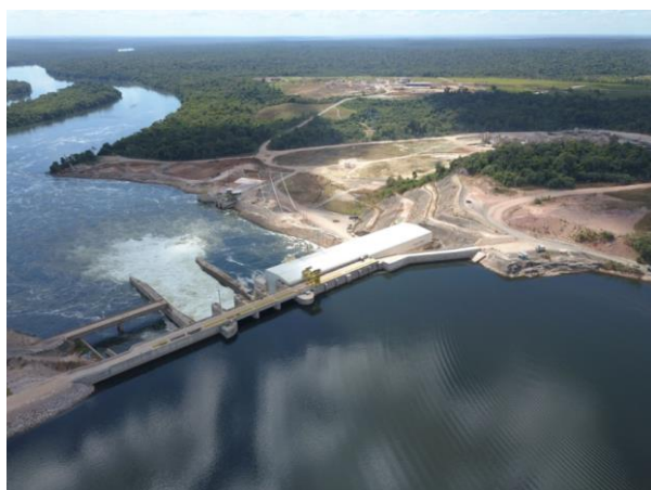
Figura 5.2 - UHE Sinop Fonte: Sinop Energia (2024).
