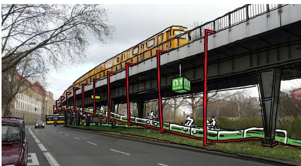
Figura 45: Trecho em elevação para otimizar o fluxo nos cruzamentos. Radbahn N1, Berlim 2016.
