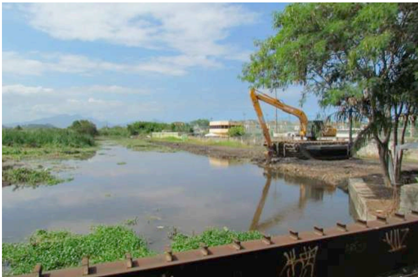
Foto 22 - Aterramento de terreno alagado para construção imobiliária
