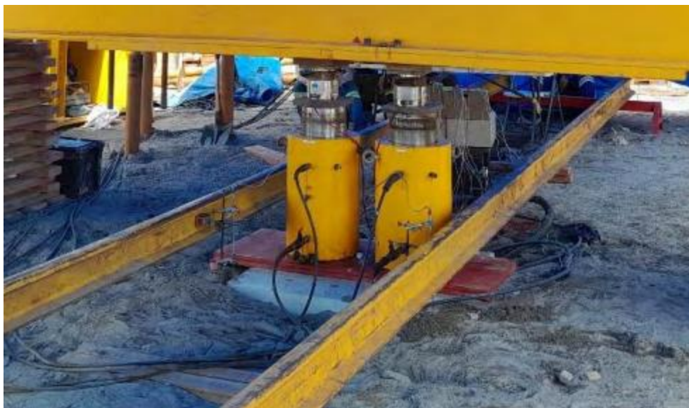
Figura 6.21 – Sistema de aplicação e leitura de cargas (modificado de EXE22202-PCE-REL-001-R00, Geoprova, 2023).
