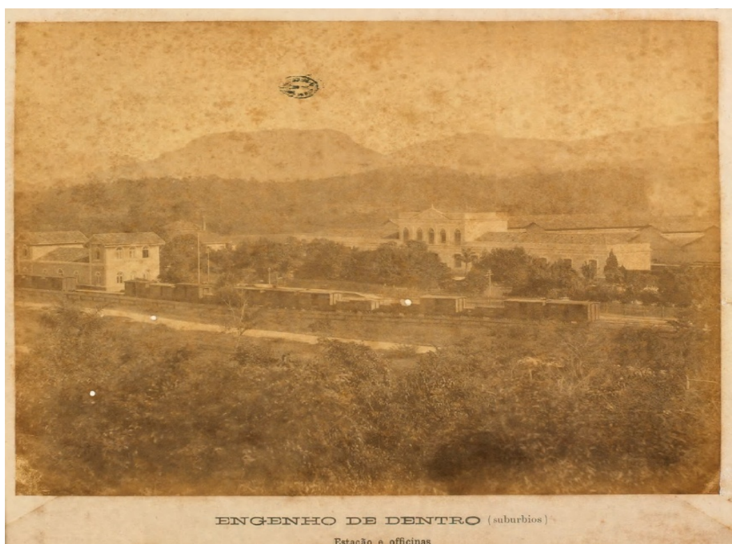
Figura 1: Engenho de Dentro (subúrbios): Estação e oficinas. s.n., 18--.. Collecção 44 vistas photographicas da Estrada de Ferro Pedro II. Biblioteca Nacional.
