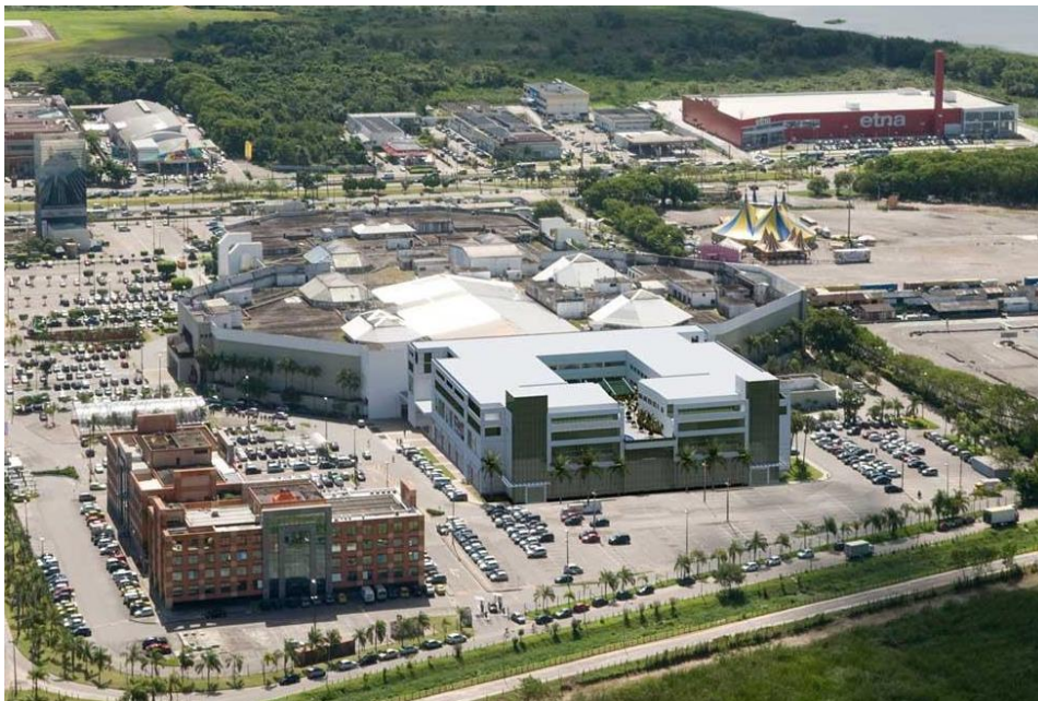
Figura 11: Estacionamento Via Parque
