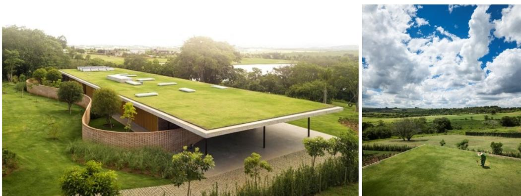
**Figura 54 e Figura 55:** Laje plana gramada que camufla a edificação no entorno e reduz a absorção térmica provocada pela insolação. Fonte: Studio MK27 (2018).
