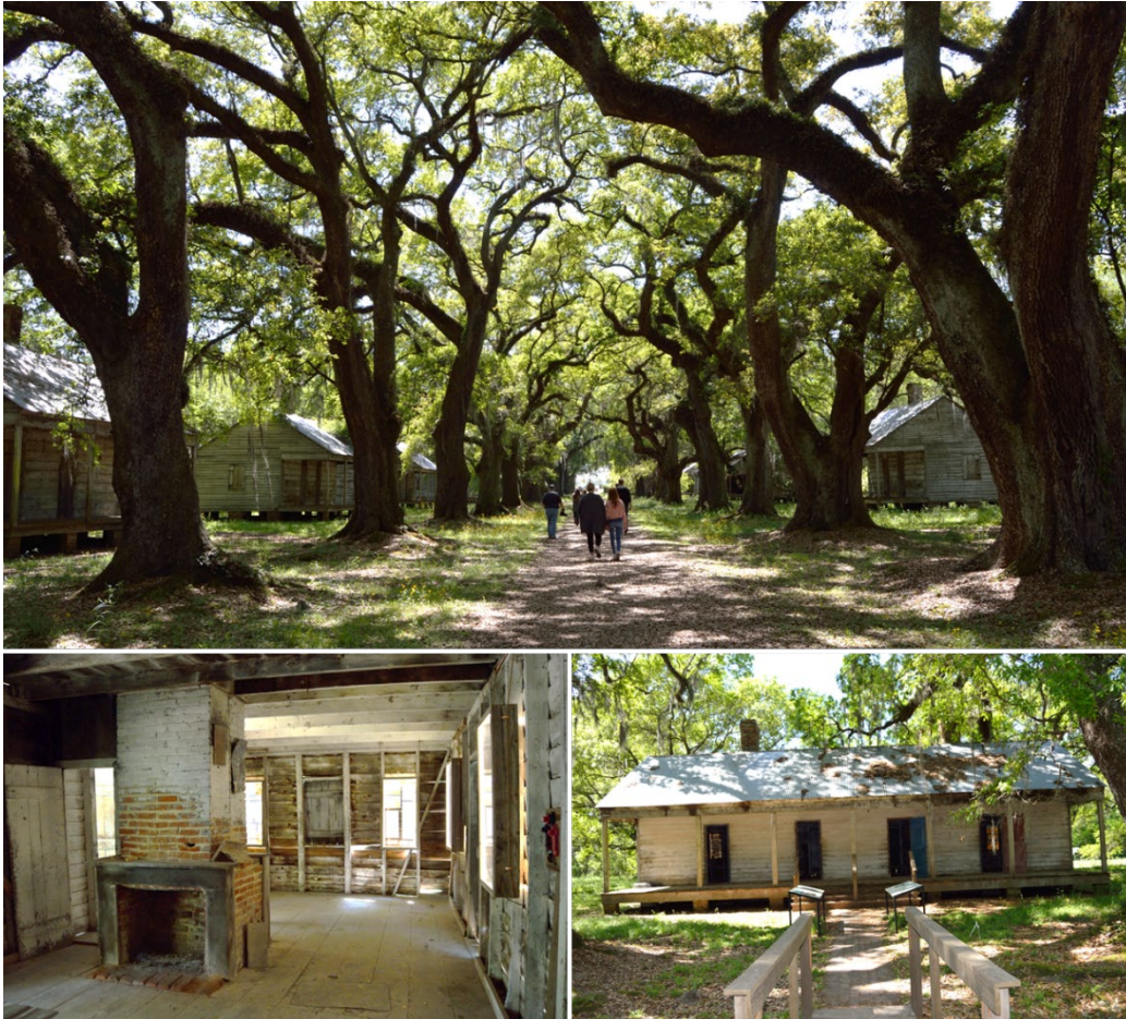
FIGURA 36 – Enslaved Cabins (senzalas), na Evergreen Plantation, Louisiana, EUA. Na fotografia de topo, vista do corredor duplo de 22 senzalas, em sua formação original; no canto inferior direito, registro a partir do corredor central em direção à senzala selecionada para visitação do público, deixando entrever as placas de sinalização com informações sobre o inventário dos escravizados na frente da construção. À esquerda, vista da sua parte interna, com displays informativos nas paredes. Fotografias: Iohana Freitas, 01/04/2019.
