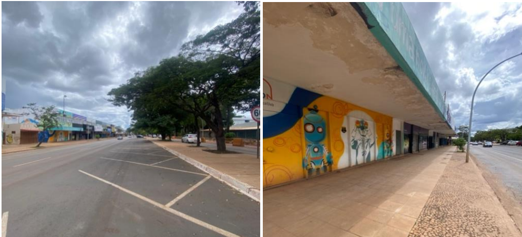
Figura 53: Avenida W3 Sul, quadra 508 Sul. (AUTORA, 2022)
