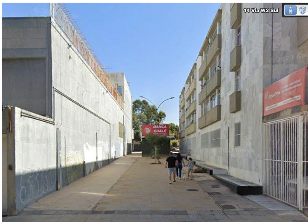
Figura 18: Beco conexão entre a W3 e W2 Sul (505 Sul). (GOOGLE EARTH, 2023)
