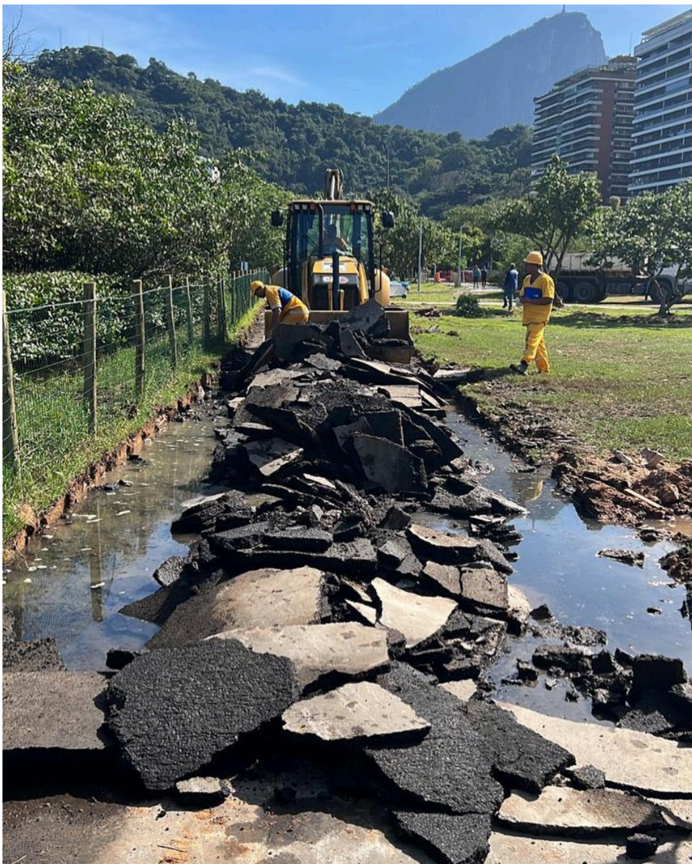
45. Registro do processo de desaterro de trecho da Lagoa Rodrigo de Freitas, Rio de Janeiro, 2023.
