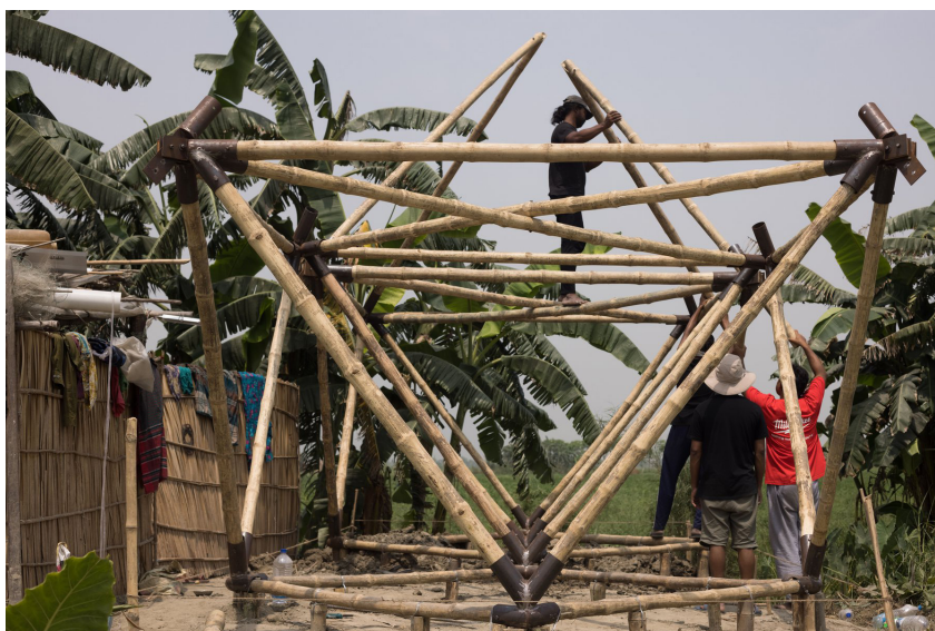
47. Foto da construção de uma das construções Khudi Bari da arquiteta Marina Tabassum em Bangladesh. Projeto em andamento desde 2020.
