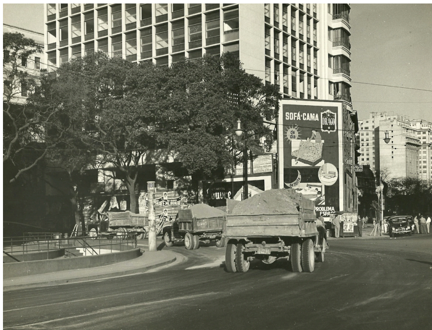
65. Caminhões transportando terra do Morro de Santo Antônio para o terreno do MAM, 1954.
