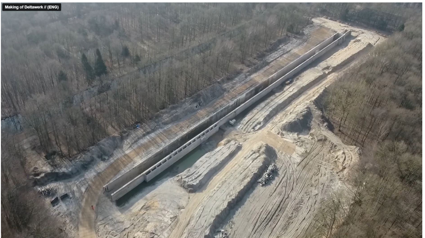
13. Modelo de teste de ondas da Deltaworks sendo transformado em monumento projetado pelos escritórios de arquitetura RAAF e Atelier de Lyon.
