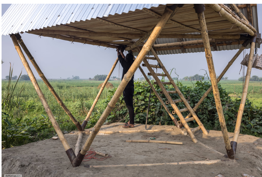
48. Foto da estrutura de pilares de uma das construções Khudi Bari da arquiteta Marina Tabassum em Bangladesh. Projeto em andamento desde 2020.
