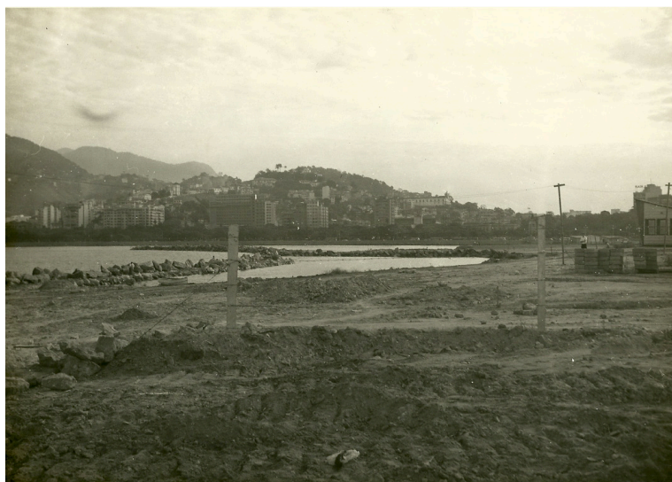
66. Foto durante processo de aterro do Parque do Flamengo na qual é possível ver a linha de pedra do enrocamento, a nova terra tomando o lugar da água e um pouco de água ainda sem ser aterrada entre o enrocamento e a terra que avança.
