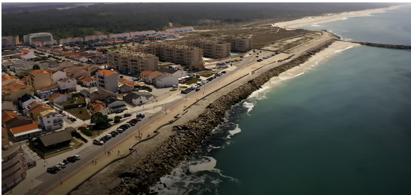
05. Barreira de pedra em Apúlia, Portugal, para conter a erosão costeira.
