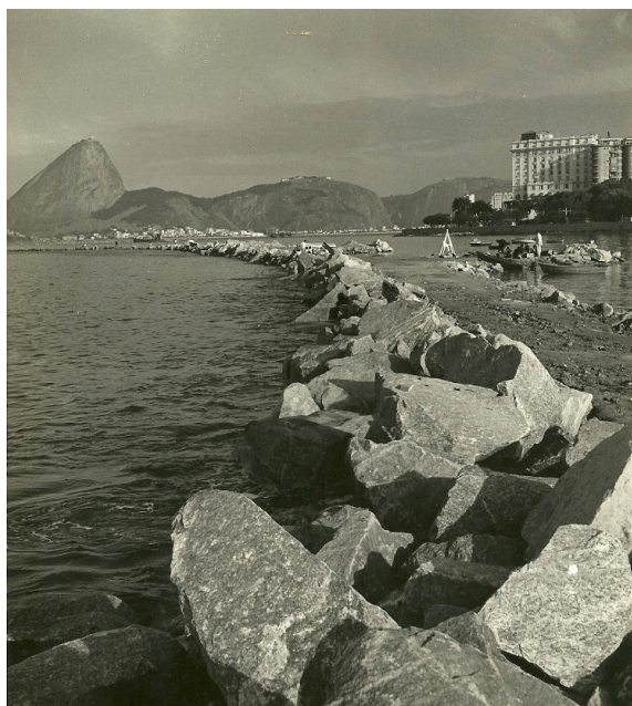
64. Linha de enrocamento durante processo de aterro do Parque do Flamengo, década de 1950.
