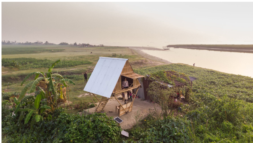
46. Vista aérea de uma das construções Khudi Bari da arquiteta Marina Tabassum em Bangladesh. Projeto em andamento desde 2020.
