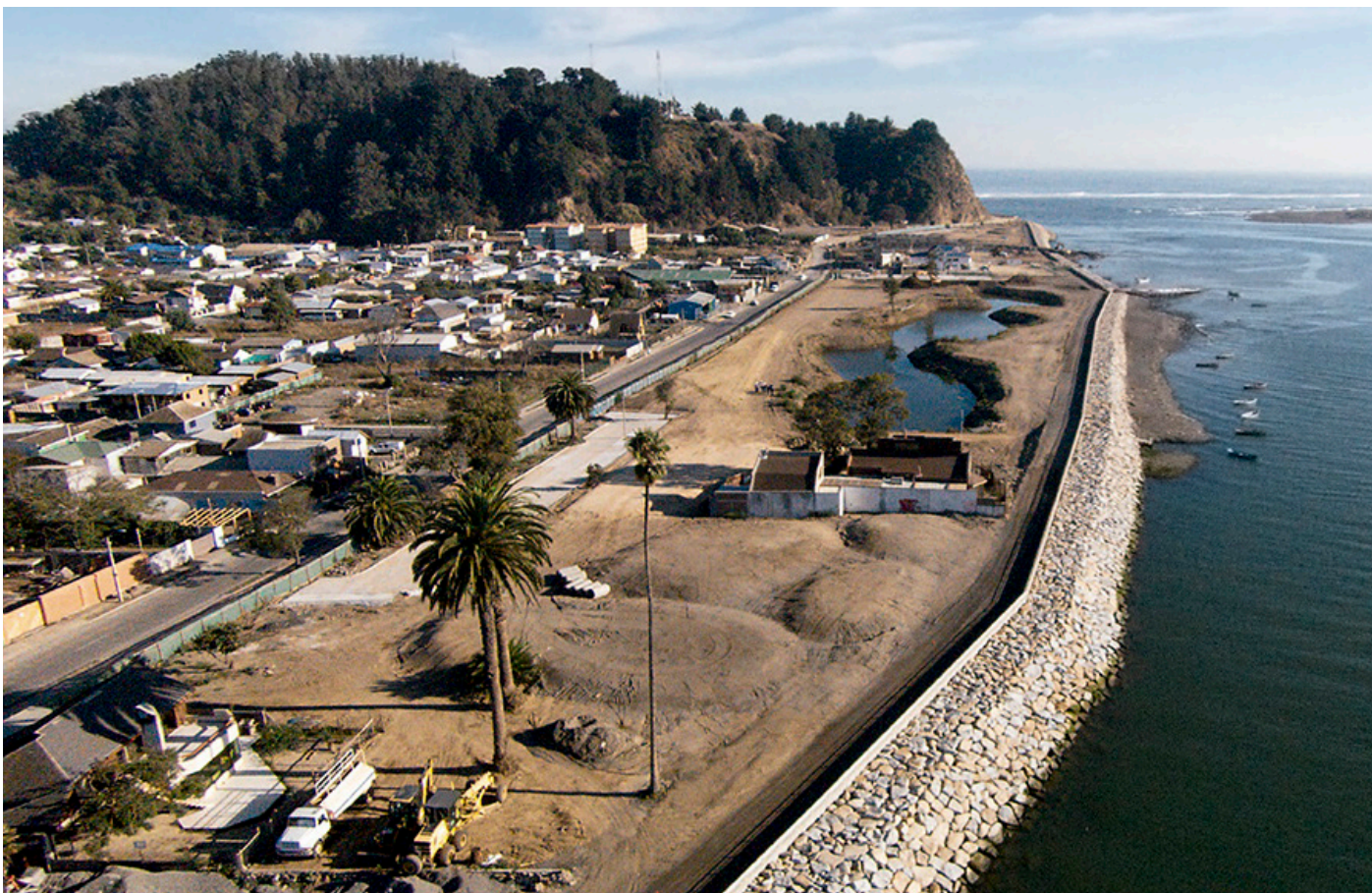
71. Vista da obra do Parque pós Tsunami do arquiteto chileno Alejandro Aravena, 2010. É possível observar simultaneamente o recuo das construções e o avanço de aterro com o enrocamento sobre as águas para a criação do parque.
