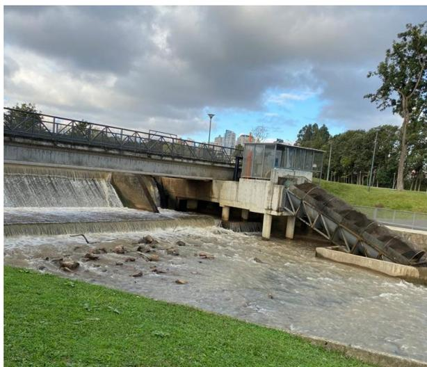
Figura 30 – Mini-usina Hidrelétrica, Parque Barigui.
