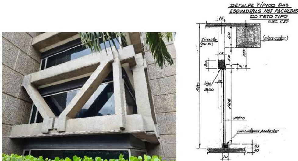
Figura 211: Torre Rio Sul. À esquerda: esquadrias de alumínio e painéis de vidro recuados da fachada. Fonte: Acervo da autora. À direita: Detalhe da estrutura de fixação das esquadrias e painéis de vidro recuados da fachada. Projectum Engenharia. Fonte: Acervo Rio Sul Shopping Center.
