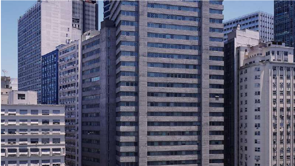
Figura 202: Henrique Mindlin. Edifício BEG. Vista da Fachada.
