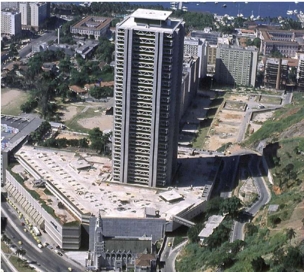
Figura 219: Torre Rio Sul. Fase final da construção. Fonte: Acervo Rio Sul Shopping Center.
