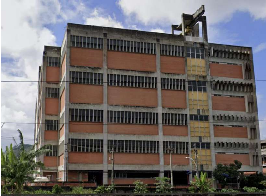
Figura 177: Indústria de Produtos Alimentícios Piraquê. Edifício Converbrás. Encontro das fachadas da Rua Monsenhor Inácio da Silva e Rua Pimenta Bueno.
