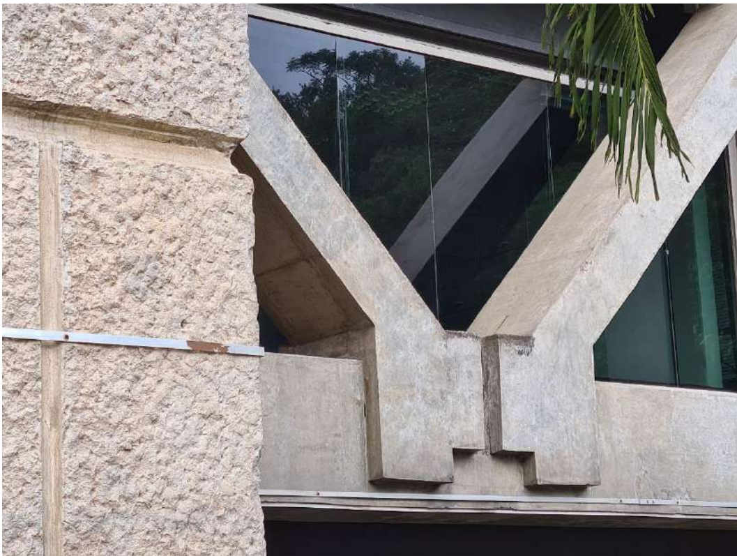
Figura 218: Torre Rio Sul. Vista ampliada do conjunto formado pela treliça e os pilones. Ampliação. Fonte: Acervo da autora.
