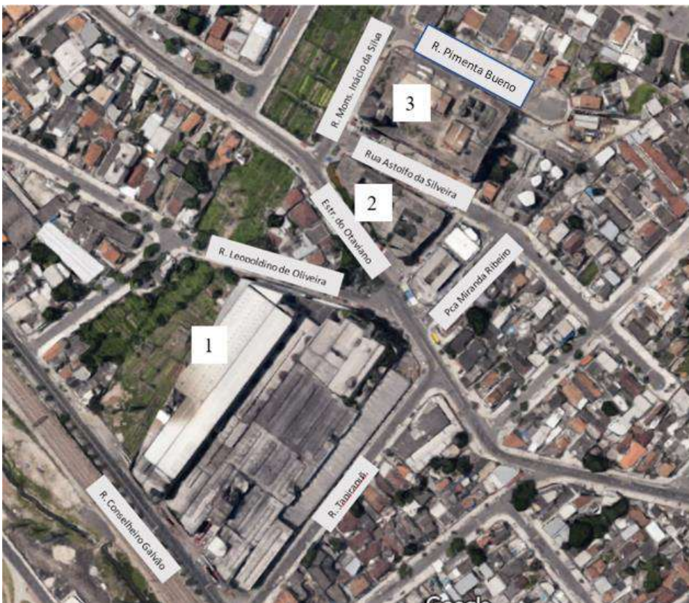
Figura 124: Indústria de Produtos Alimentícios Piraquê. Vista aérea e esquema de nomeação das ruas do entorno e setorização das edificações elaborado pela autora: 1 – Fábrica de Massas e Biscoitos; 2 – Edifício Jerônimo Ometto; 3 – Edifício Converbrás.
