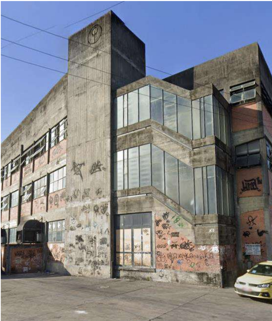
Figura 136: Indústria de Produtos Alimentícios Piraquê. Bloco Conselheiro Galvão-Tapirapuã. Fachada com escada na esquina. Fonte: Google Maps. Disponível em: < https://maps.google.com >.
