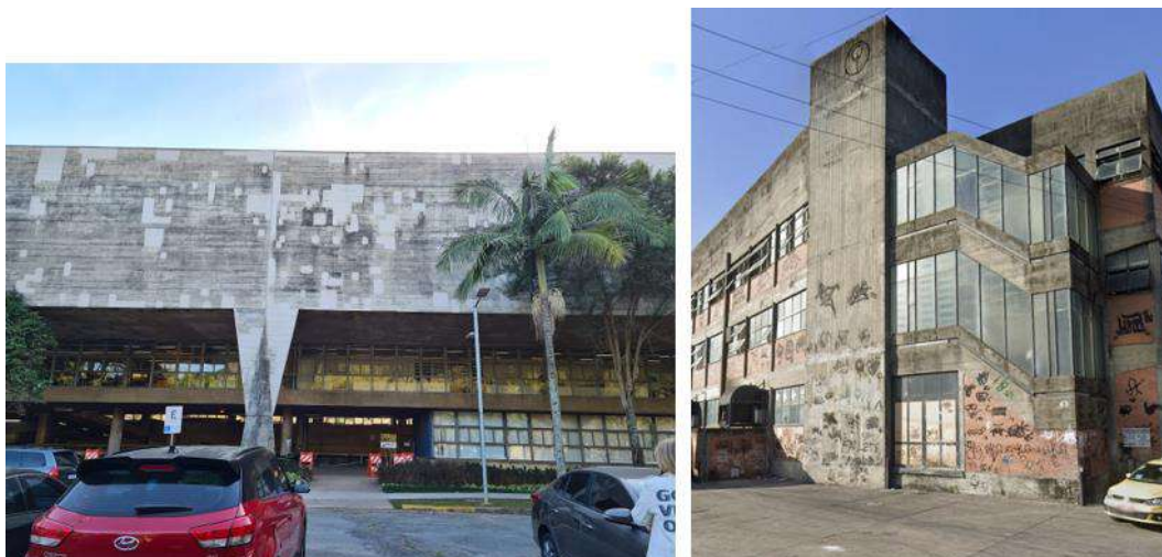
Figura 1: À esquerda: João Batista Vilanova Artigas e Carlos Cascaldi, FAUUSP. Fachada após recuperação estrutural.
