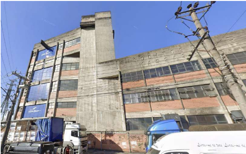
Figura 159: Indústria de Produtos Alimentícios Piraquê. Blocos Ampliação Conselheiro Galvão. À esquerda, o último e à direita o primeiro a ser construído. Fachada. Fonte: Google Maps. Disponível em: < https://maps.google.com >.
