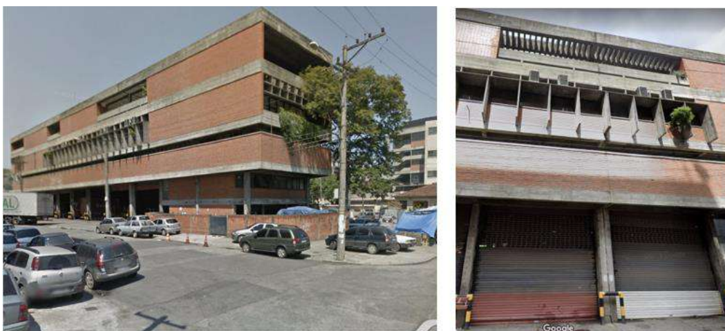
Figura 163: Indústria de Produtos Alimentícios Piraquê. Edifício Jerônimo Ometto. Fachada para a Rua Astolfo Silveira.
