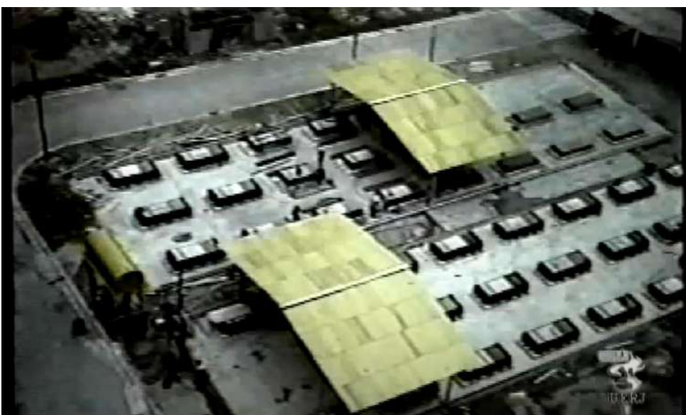
Figura 111: UERJ. Conjunto Escolar. Canteiro de obras – Setor de Pré-fabricação. Fonte: Youtube. Disponível em: < https://www.youtube.com/watch?v=4czvMkrkWrU >.
