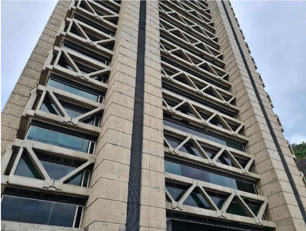
Figura 200: Torre Rio Sul Shopping. Vista da treliça da fachada. Fonte: Acervo da autora.
