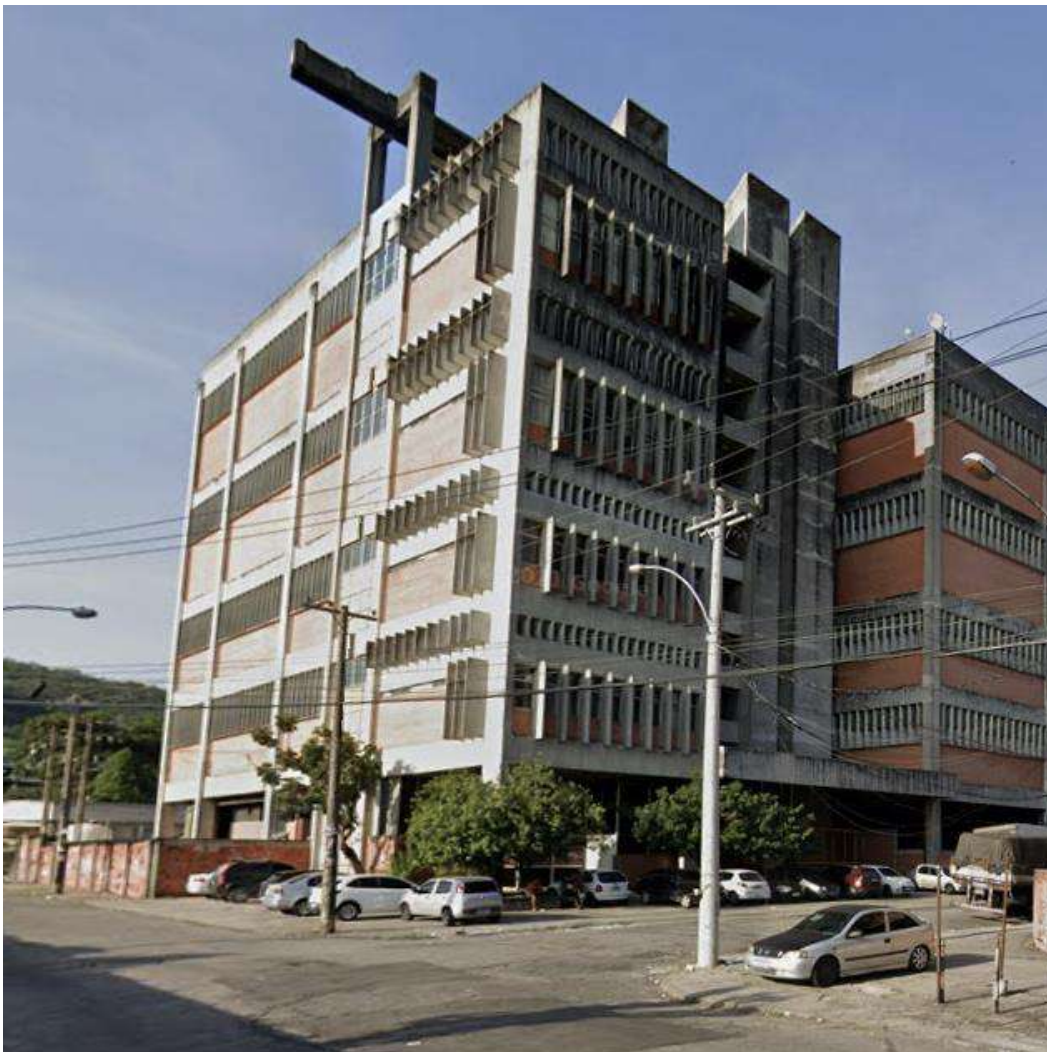
Figura 179: Indústria de Produtos Alimentícios Piraquê. Edifício Convergência. Encontro das fachadas da Rua Monsenhor Inácio da Silva e da Rua Astolfo da Silveira.
