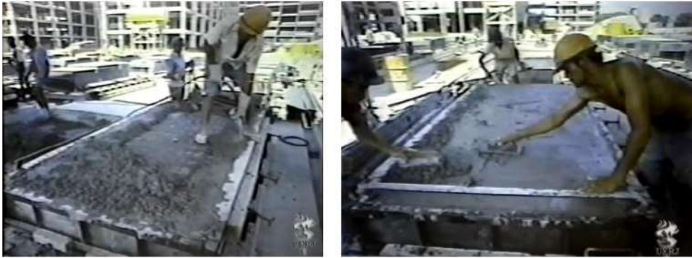
Figura 109: UERJ. Conjunto Escolar. Concretagem de elemento pré-moldado no canteiro de obras. Fonte: Youtube. Disponível em: < https://www.youtube.com/watch?v=4czvMkrkWrU >.
