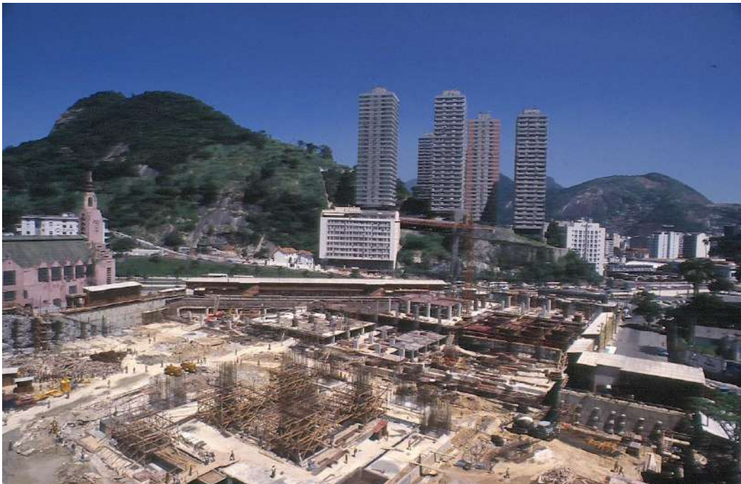
Figura 192: Torre Rio Sul. Canteiro de obras, no início da construção. Ao fundo, as torres do Condomínio Morada do Sol.
