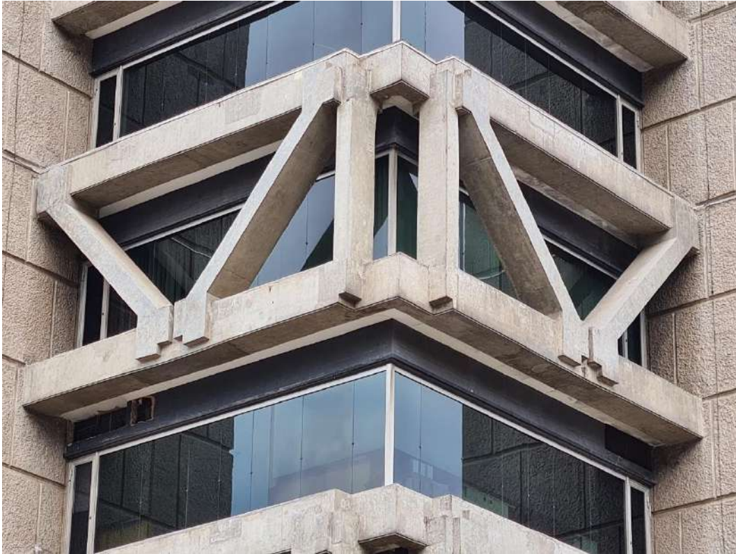
Figura 217: Torre Rio Sul. Vista ampliada do conjunto formado pela treliça e os pilones. Fonte: Acervo da autora.
