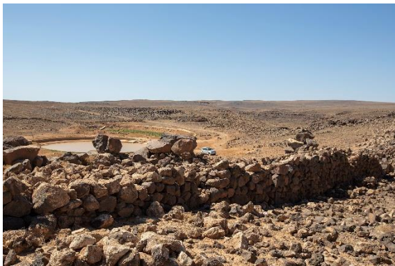
a - Barragem de Jawa
