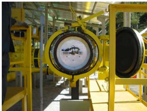
Figura 77– Pig Acústico no lançador.
