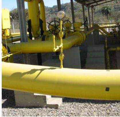
Figura 78 – Dreno utilizado para simulação do vazamento.
