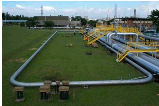
Figura 15 – Loop de testes para pigs do DTSE.
