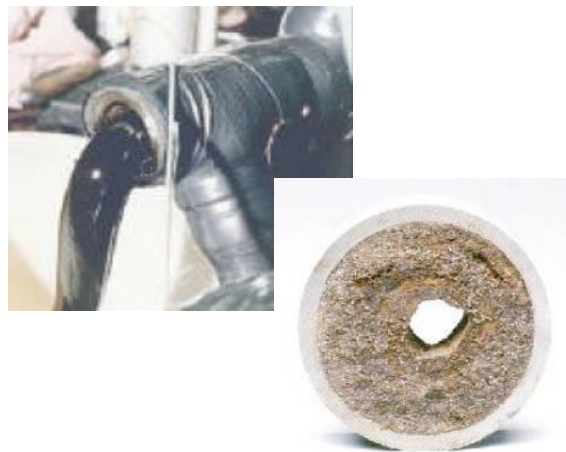
Figura 1.3: Aumento de viscosidade e bloqueio de tubulação com a deposição. Petrobras.
