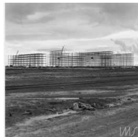
Figura 18. Esplanada dos ministérios em construção. Marcel Gautherot, 1959. Acervo de fotografia do Instituto Moreira Salles.
