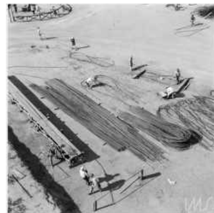
Figura 17. Congresso Nacional em construção. Marcel Gautherot, 1959. Acervo de fotografia do Instituto Moreira Salles.
