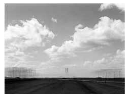
Figura 21. Esplanada dos Ministérios em construção. Marcel Gautherot, 1959. Acervo de fotografia do Instituto Moreira Salles.
