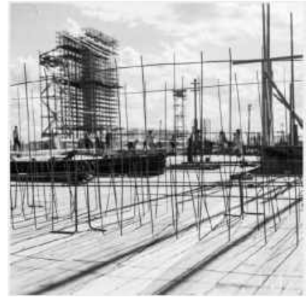
Figura 19. Congresso Nacional em construção. Marcel Gautherot, 1959. Acervo de fotografia do Instituto Moreira Salles.
