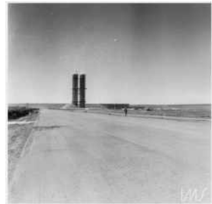
Figura 20. Congresso Nacional em construção. Marcel Gautherot, 1959. Acervo de fotografia do Instituto Moreira Salles.
