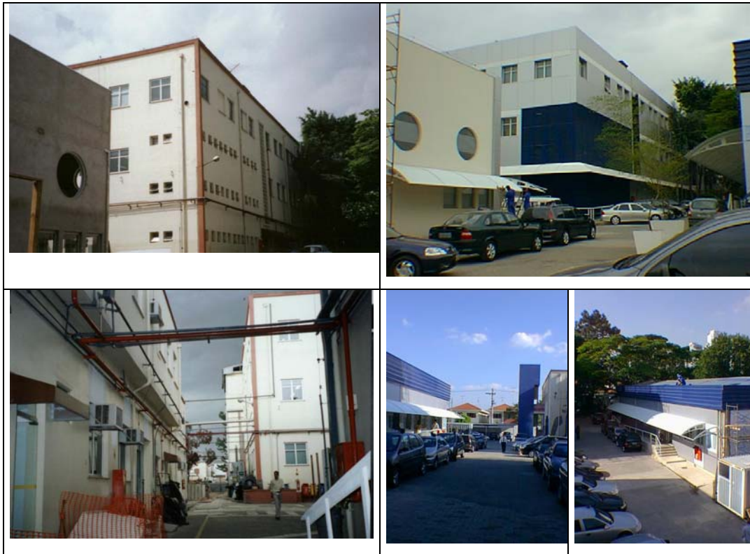
Figura 7.9– Fachada das edificações, antes e depois da reforma
