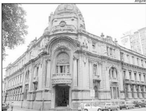
A ANTIGA SEDE do Dops, na Rua da Relação: necessidade de obras
