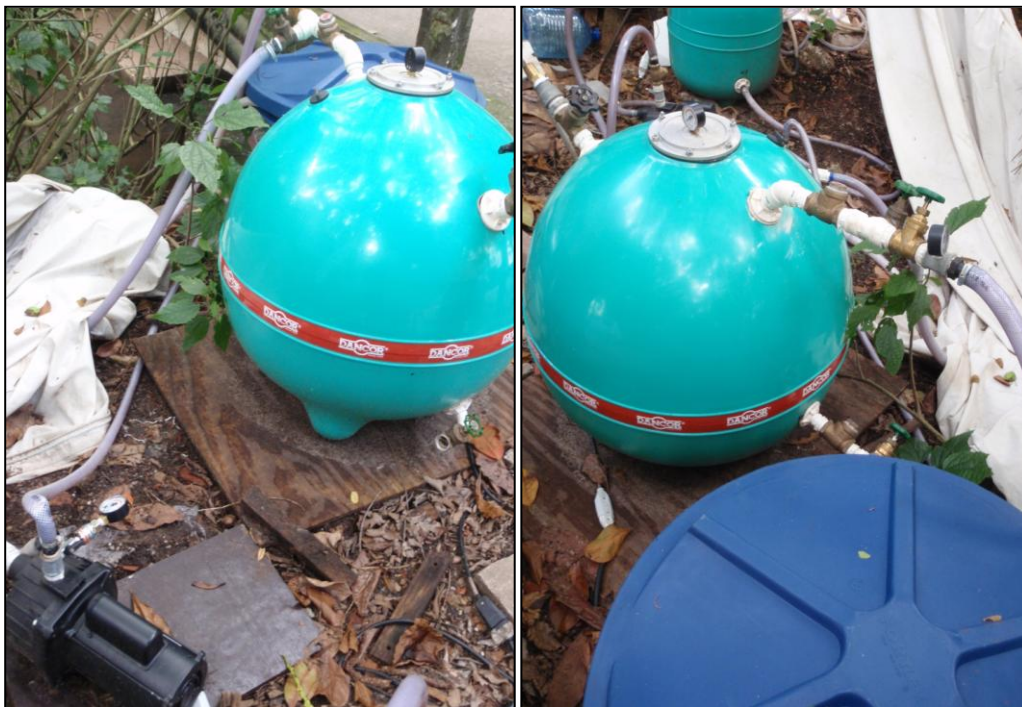
Figura 4.18 – Câmara de mistura e tanque de reagente montados em campo.
