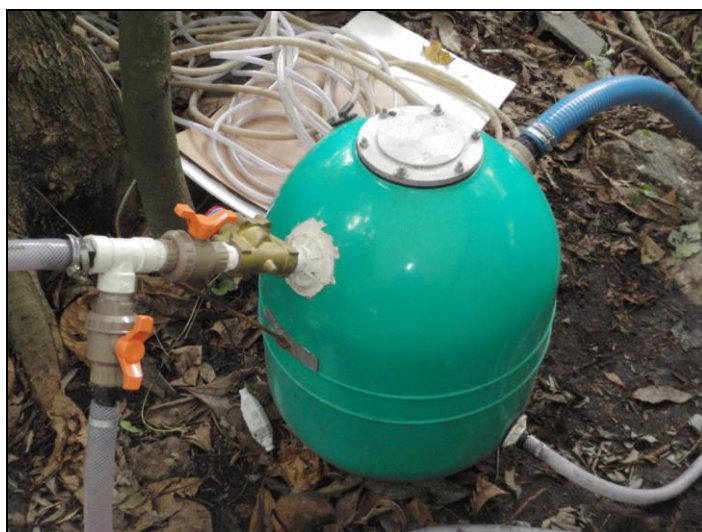
Figura 4.17 – Tanque de Armazenamento montado em campo.
