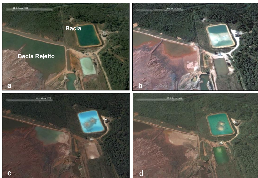
Figura 3.12 a, b, c e d – Série Histórica do tratamento da bacia de rejeitos da Cia. Mercantil e Industrial Ingá.
