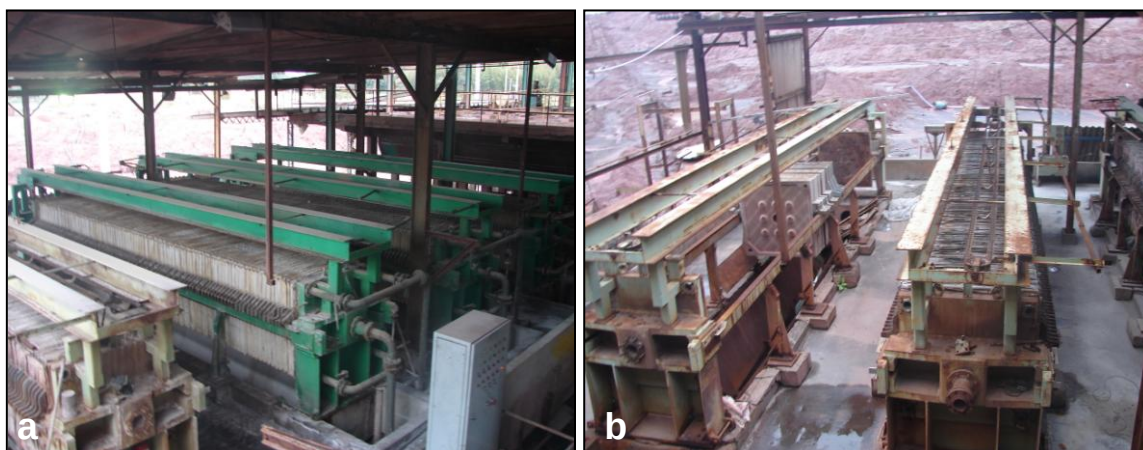
Figura 3.9 a e b – Filtros prensa utilizado durante o tratamento, após a precipitação química. FONTE: PUC-Rio (2008).
