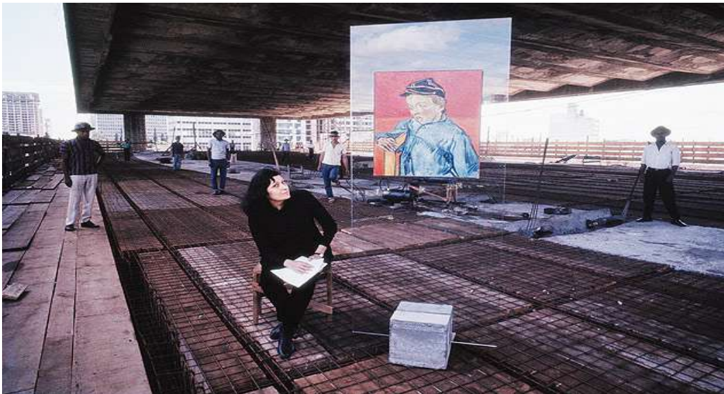
Figura 7 - Lew Parrella, Fotografia do canteiro de obras do Masp. Revista Realidade nº 15, junho de 1967.
