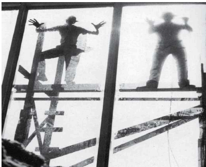
Figura 76 – Miroslav Javurek, Colocação dos vidros nas fachadas. 1960.
