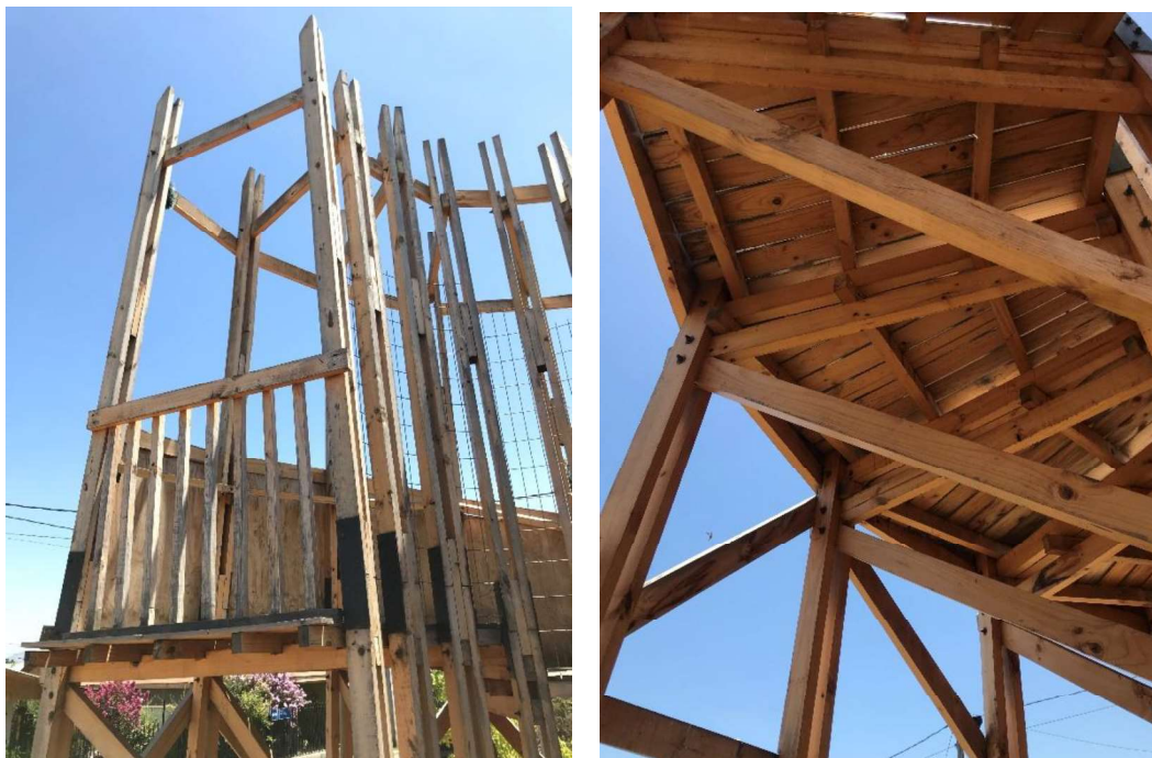
Figuras 19 e 20: Elementos verticais e treliças estruturais da obra Fonte: Autor
