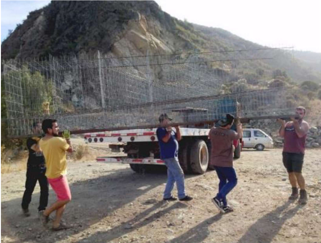
Figura 65: Estruturas sendo levadas para o local de inserção da obra Fonte: Caderno de memórias de título do Mirador Yacal
