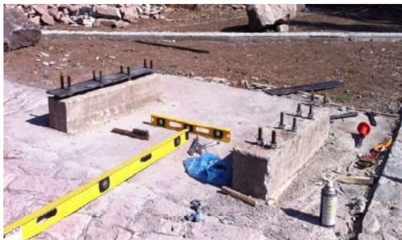
Figura 40: Bloco da fundação com as sapatas que se conectam à estrutura de metal, após o preenchimento da armação de ferro com concreto
