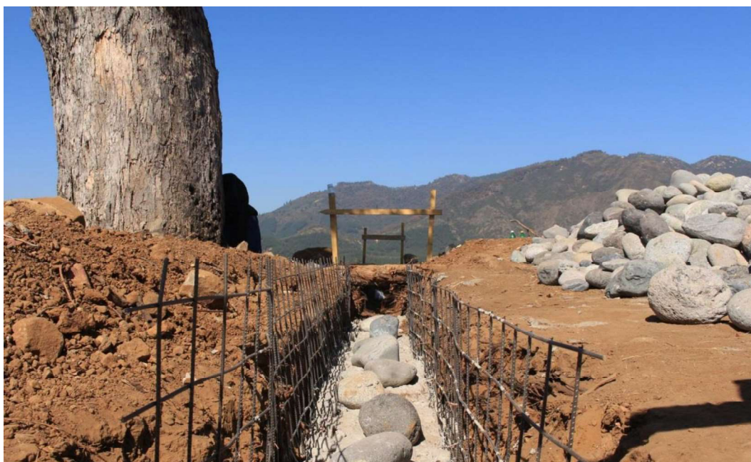
Figuras 52 e 53: Processo de melhoramento do solo após as escavações no terreno Fonte: Caderno de memórias de título da Mesona del Rio
