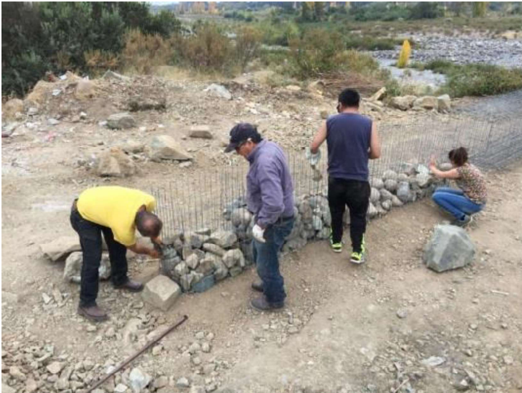
Figura 69: Preenchimento das gaiolas com pedras do rio e das pedreiras da região Fonte: Caderno de memórias de título do Mirador Yacal
