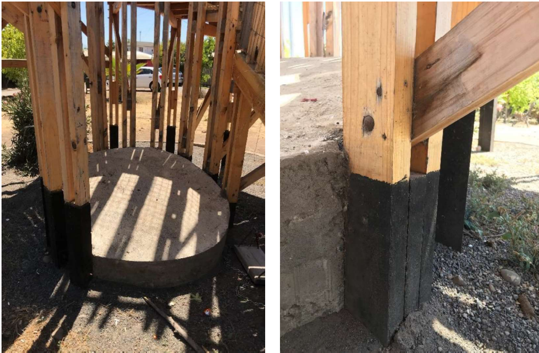
Figuras 23 e 24: Elemento estrutural de fundação e encontro com as peças de madeira treliçadas Fonte: Autor
