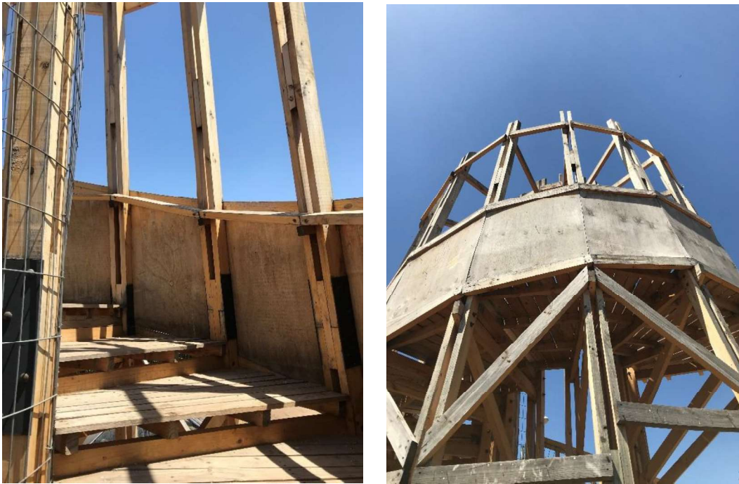
Figuras 21 e 22: Patamar das escadas internas e fachada externa em espiral
