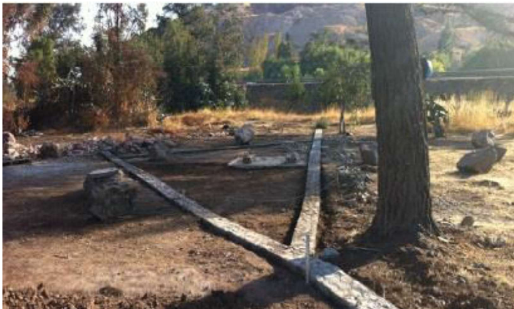
Figura 43: Processo de construção do caminho de pedras da praça
