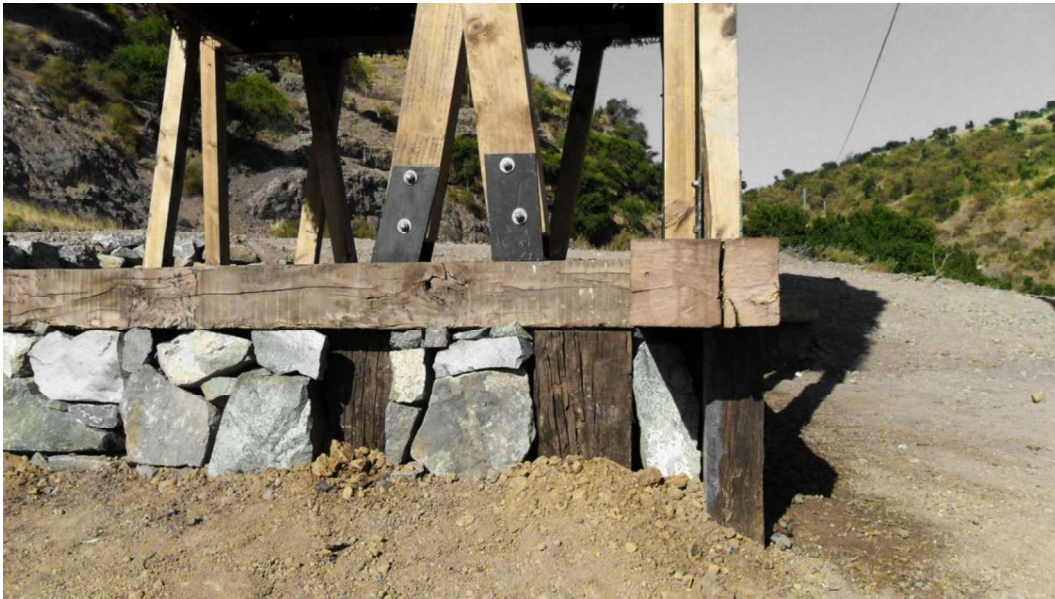
Figura 126: Base da obra feita de pedras e madeira
