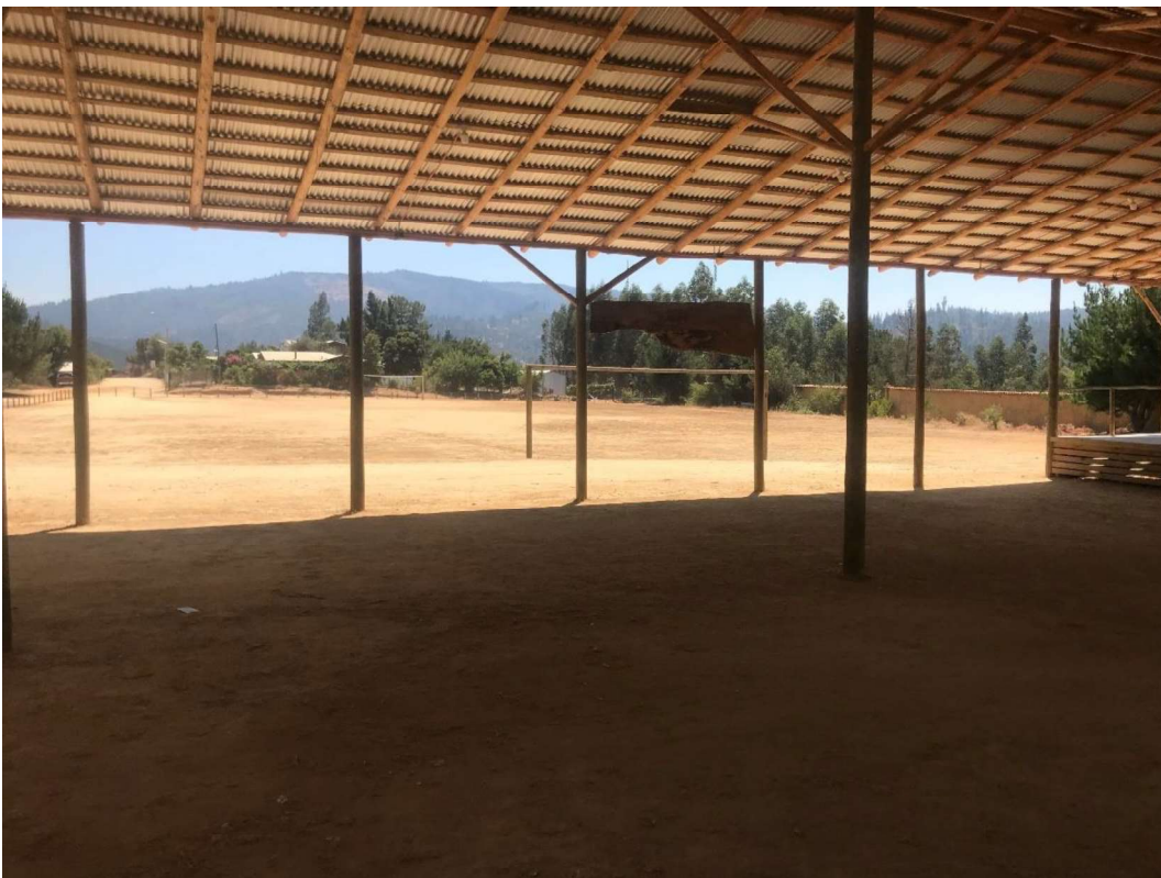
Figura 91: Pavilhão construído no terreno após a retirada da obra de Gustavo Torres Fonte: Autor
