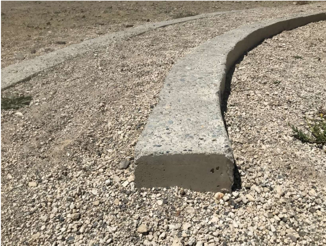
Figura 78: Detalhe das “rampas” ou “coroas” de concreto que circundam as pedras da obra Granos de Arena Fonte: Autor
