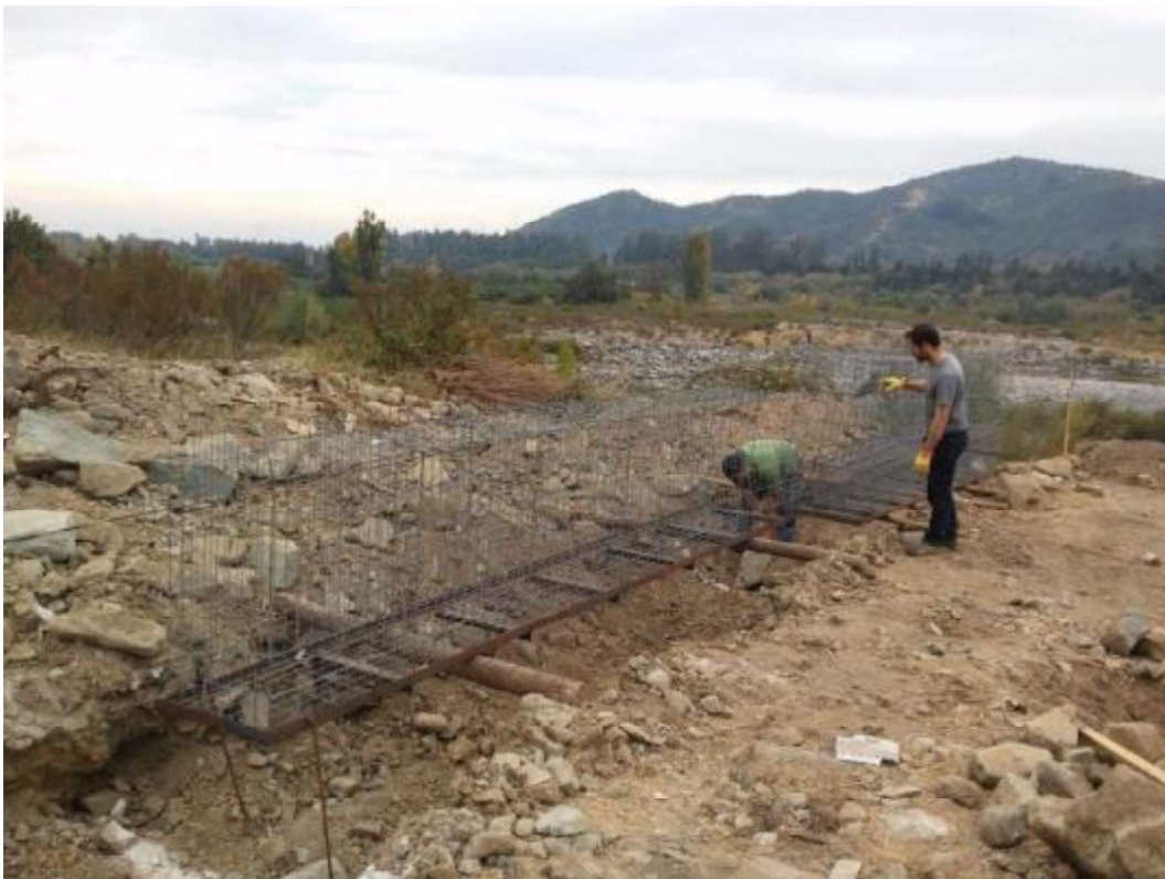
Figura 66: Processo de nivelamento da estrutura com postes de madeira Fonte: Caderno de memórias de título do Mirador Yacal
