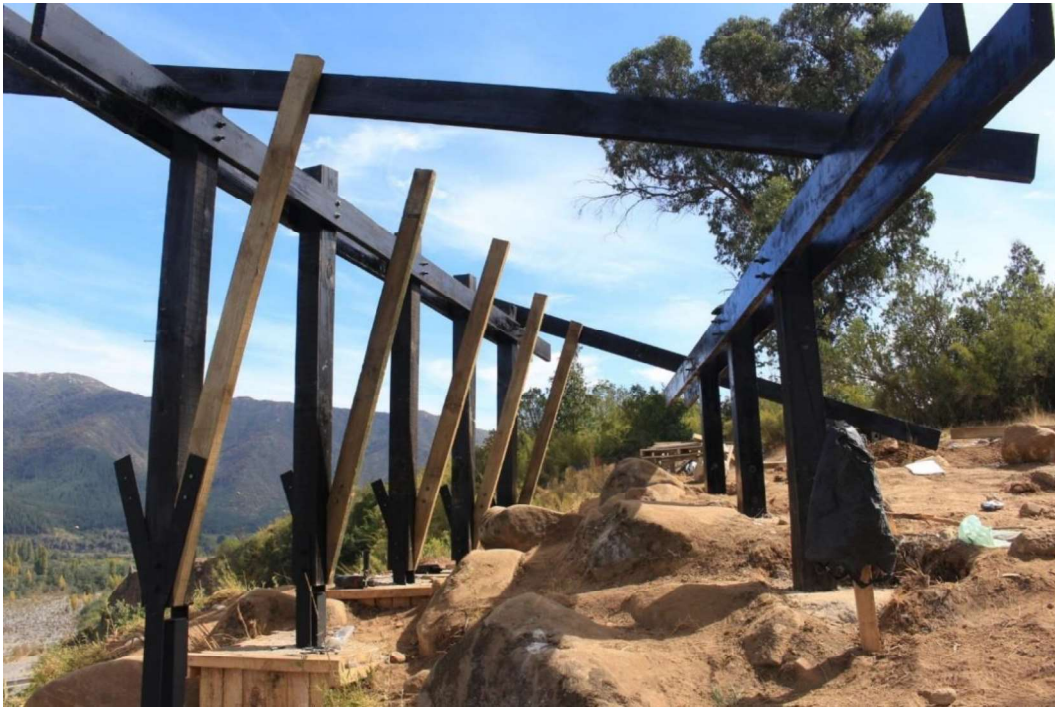
Figura 56: Instalação das vigas que sustentam o patamar do mirante Fonte: Caderno de memórias de título da Mesona del Rio
