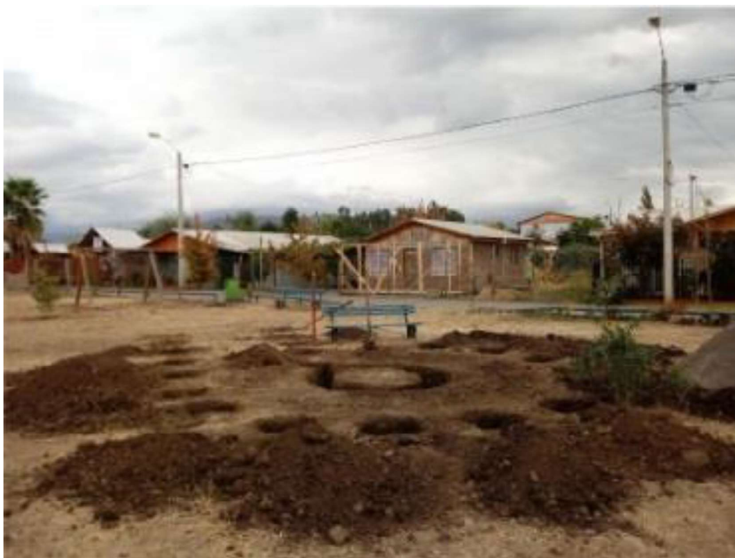
Figura 26: Escavações no terreno para implantação da obra Fonte: Caderno de memórias de título de Nathalie Guerrero
