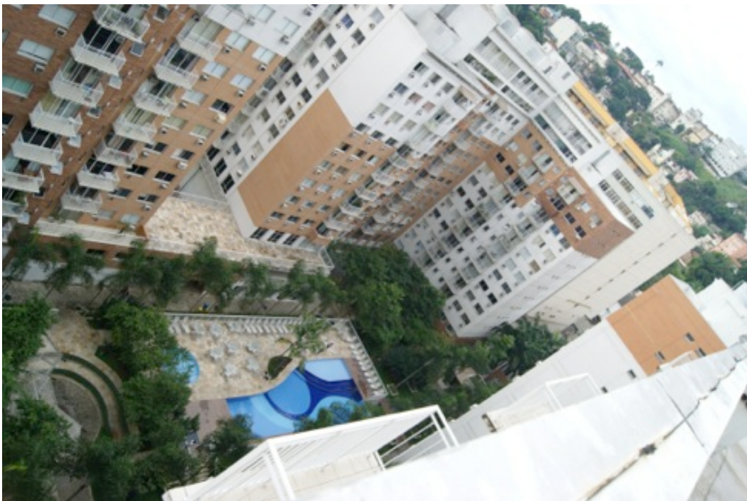
Figura 4.1 – Foto de parte das áreas comuns e fachadas do condomínio Fonte: arquivo pessoal.
