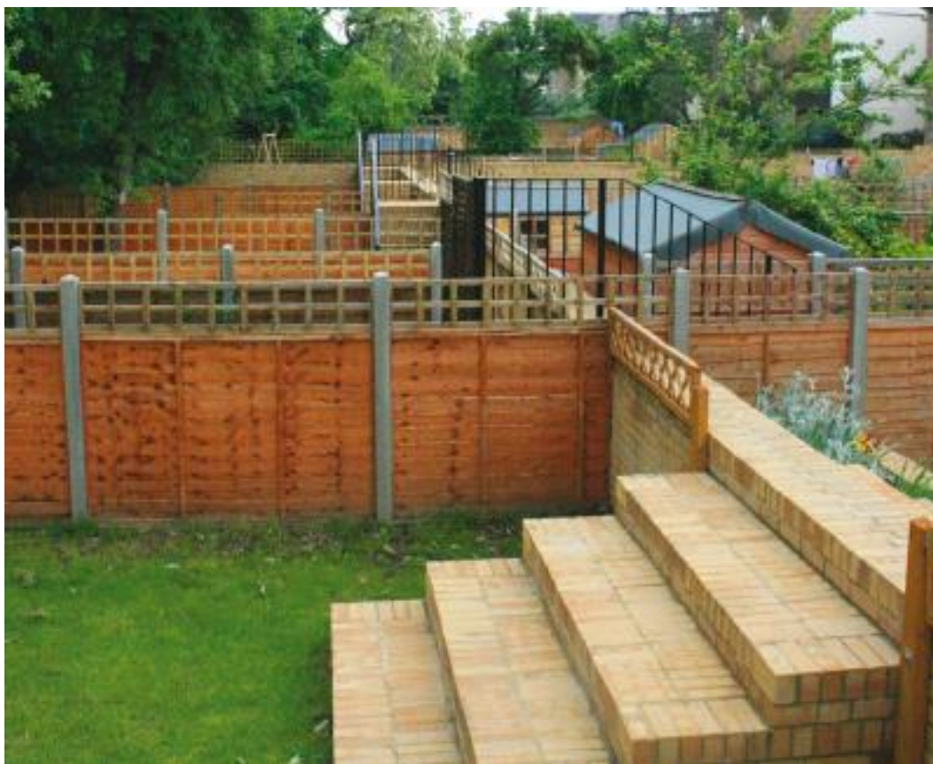
Figura 56 - Medida de proteção das residências da planície de inundação. Fonte: EA (200?).
