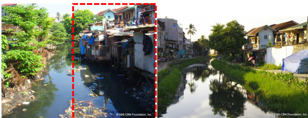
Figura 47 - Remoção de propriedades e reabilitação das margens. Antes e depois do trecho Quirino a Ponte Pedro Gil. A linha em vermelho representa as habitações removidas. Fonte: Pasig River Watch 91 , adaptado pela autora.
