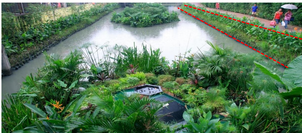
Figura 45 - Ilhas de aeração no Mercado de Paco. Os wetlands , que o relatório de desempenho se refere são essas camadas de margem vegetada, destacadas em vermelho, construídas para auxiliar na infiltração e redução de poluentes que chegam às águas. Fonte: Biomatrix Water 89 , adaptado pela autora.
