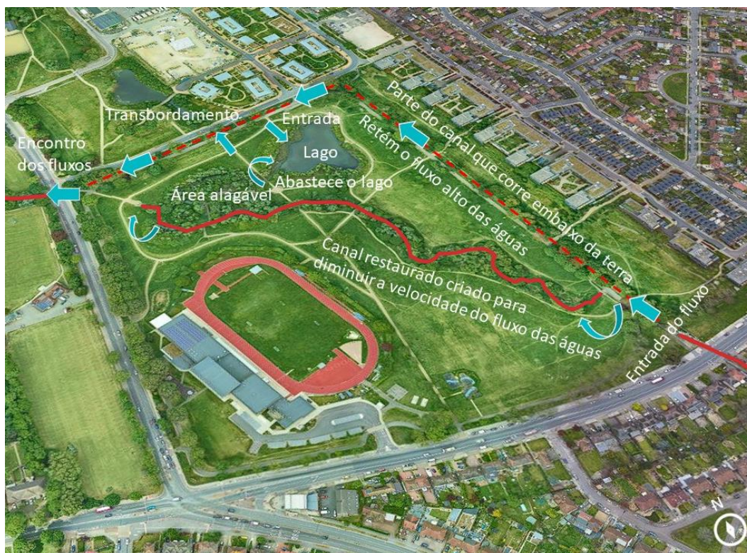
Figura 55 - Mudanças no fluxo de água para diminuir a velocidade das águas escoadas, no Sutcliffe Park. Fonte: Google Earth 98 e RESTORE (2017), adaptado pela autora e tradução nossa.
