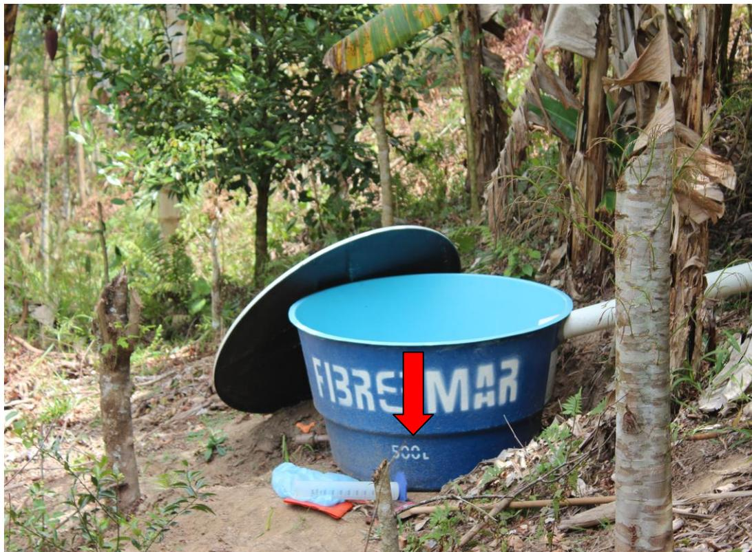
Figura 23: Demonstração da caixa coletora de 500 L instalada com o objetivo de não gerar maiores intervenções na estrutura da vegetação do Sistema Agroflorestal – Sítio Abaetetuba – Localidade Toca da Onça – Lumiar – Nova Friburgo/RJ.
