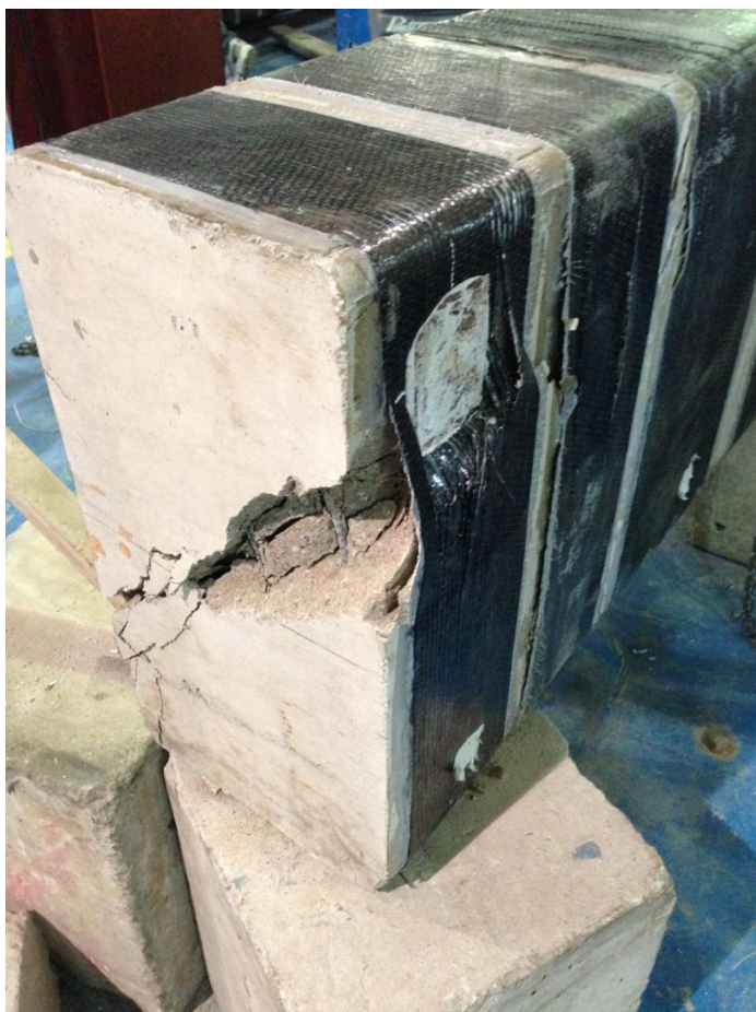
Figura A.4.6 – Viga VRB-1 após ensaio.
