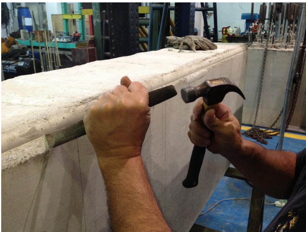
Figura A.3.1 – Apicoamento para regularização dos cantos.
