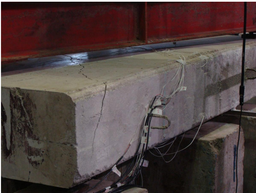
Figura A.2.3 – Fissura fora da região de observação.
