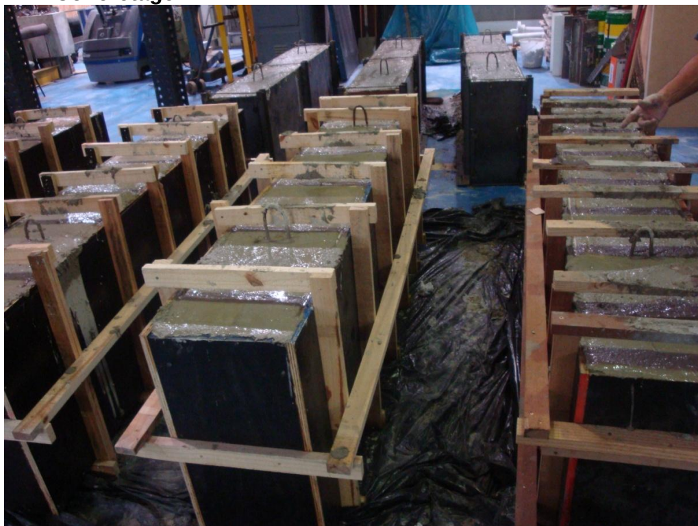
Figura A.1.1 – Vigas recém concretadas.
