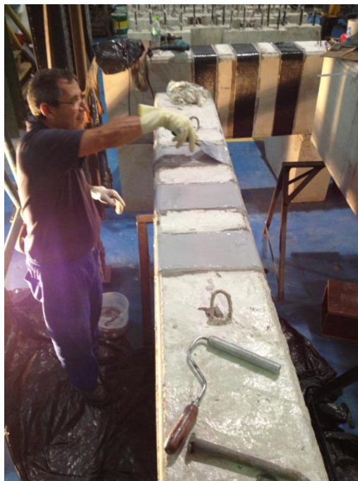
Figura A.3.4 – Aplicação da base (1209-TX) e de segunda camada do tecido de fibras de carbono.
