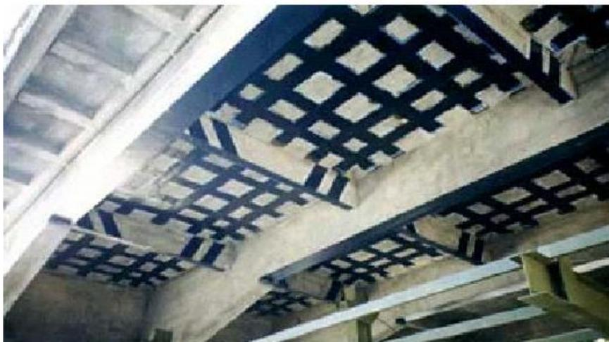
Figura 3.1 – Reforço de lajes à flexão e de vigas à flexão e à força cortante (Silva Filho, 2007).
