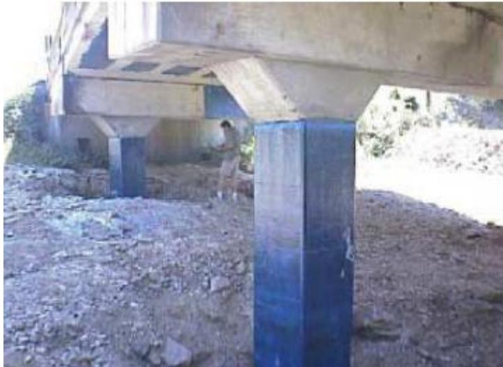
Figura 3.2 – Confinamento de pilares com CFC (Silva Filho, 2007).
