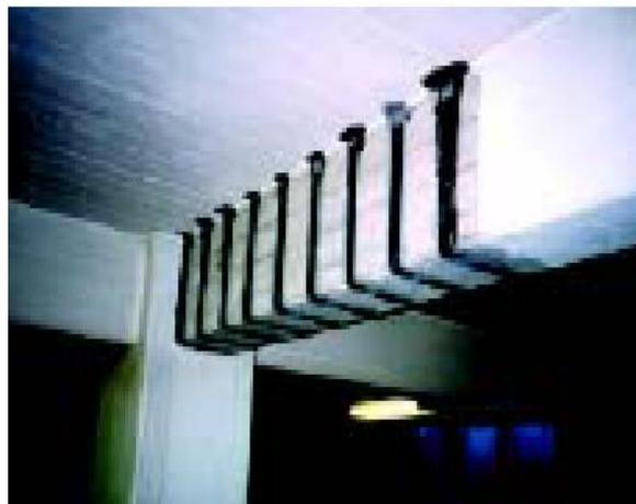
Figura 3.3 – Reforço de vigas à flexão e à força cortante com CFC (Spagnolo, 2008).
