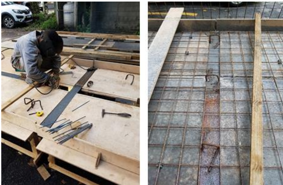
Figura 3.6. Montagem da viga
