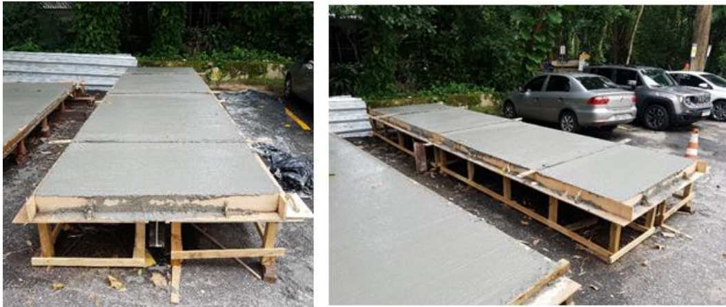
Figura 3.7. Viga após a concretagem
