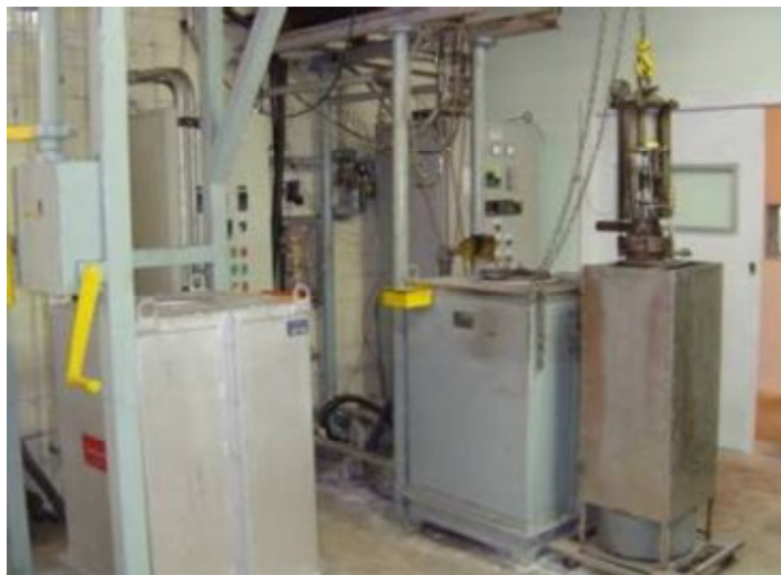
Figura 62 – Forno elétrico vertical.
