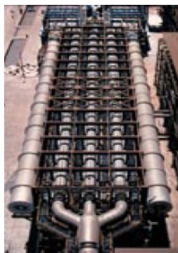
Figura 17 – Reformador de gás natural utilizada pela tecnologia Midrex. (19)
