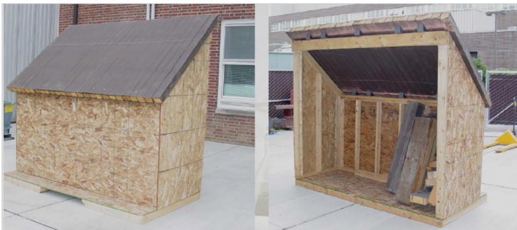
**Figura 10 – Placas de compósito polimérico de óleo de soja e fibras vegetais (Fonte: ACRES, 2007)**
