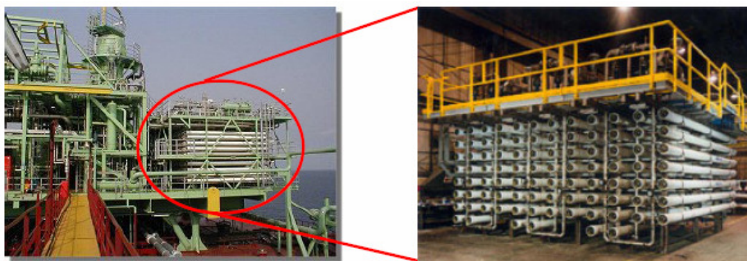
Figura 2.12: (a) Arranjo típico de dois estágios para módulos de permeação em URS de plataformas marítimas; (b) Fotos de URS, reproduzidas de [53].
