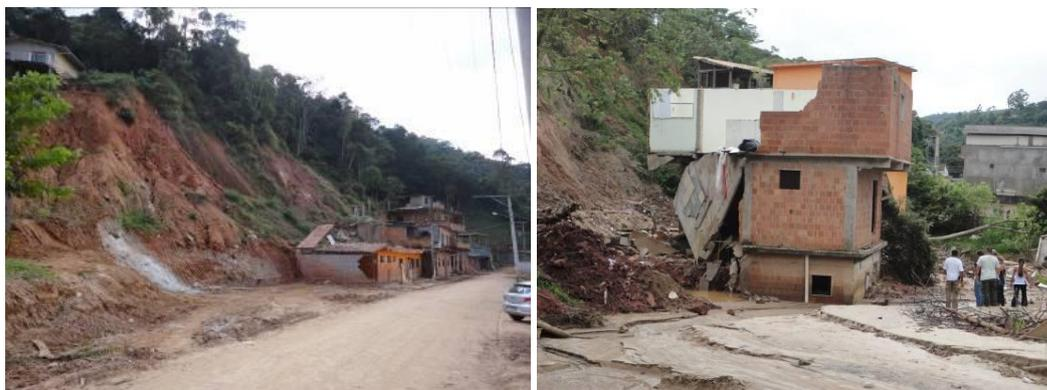
Figuras 63 e 64: Exemplos de ocupações em sopés de encostas atingidas por deslizamentos após as chuvas de janeiro de 2011 dentro da área de estudo. Fonte: fotos da autora (04/06/2011).
