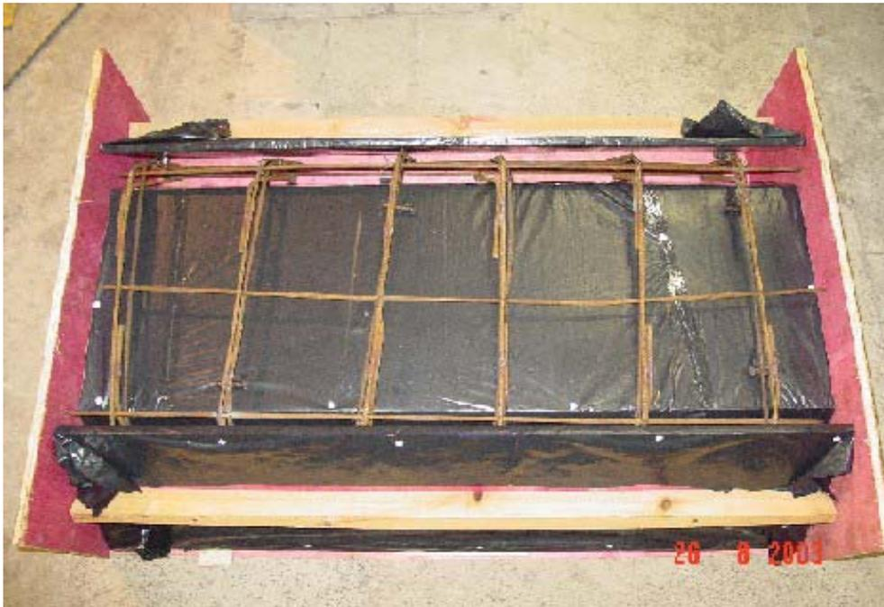
Figura 11 - Forma e armadura da calha.
