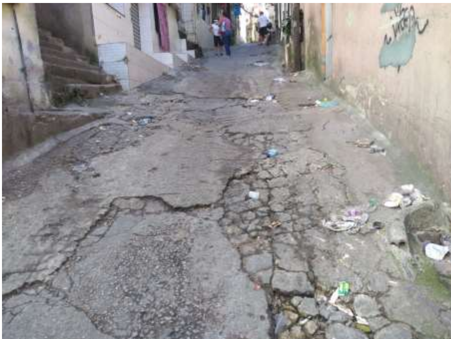
Figura 59 – Resíduo sólido descartado inadequadamente na rua – Rampa da Vila Verde.
