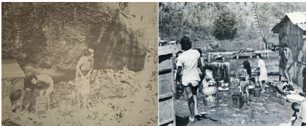
Figura 10- Bicas coletivas de água na Rocinha
