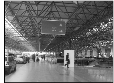
Figura 72 – Meio-fio de embarque.
