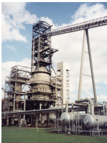
Torre de Extração de Óleo
