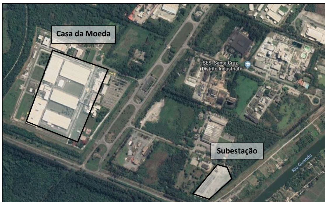
Figura 21 - Vista superior da localização da Subestação Light Zin. Fonte: Google Earth , 2019.
