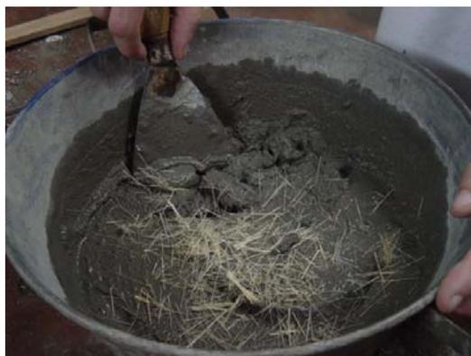
Figura 5.5 – Mistura manual da argamassa com fibra de sisal.
