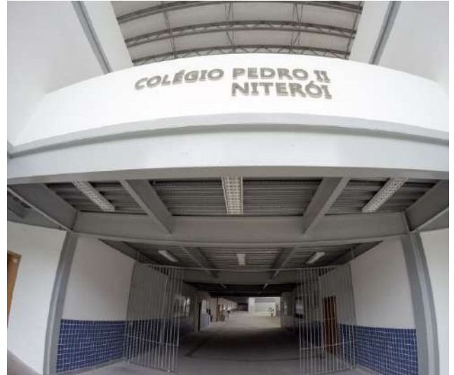
Figura 43E – Obra finalizada do Pátio Interno e de parte da Fachada do Campus Niterói.
