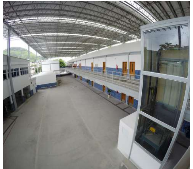
Figura 43G – Pátio interno e elevador finalizados.
