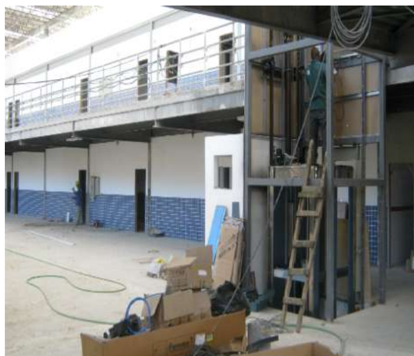
Figura 43C – Construção do elevador no pátio interno. Foto de julho de 2015.
