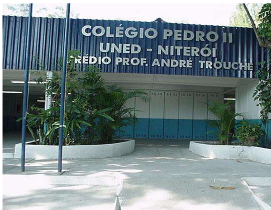
Figura 36 – Fachada do primeiro Prédio da UNED Niterói, o Prof. André Trouche. Foto disponível no Blog do Campus Niterói: http://informecp2niteroi.blogspot.com/ . Acesso em: 06 dez. 2020.
