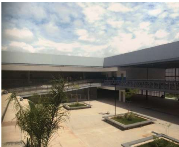
Figura 56 – Estrutura externa do CII Caxias (Arquivo NUDOM, 2018).
