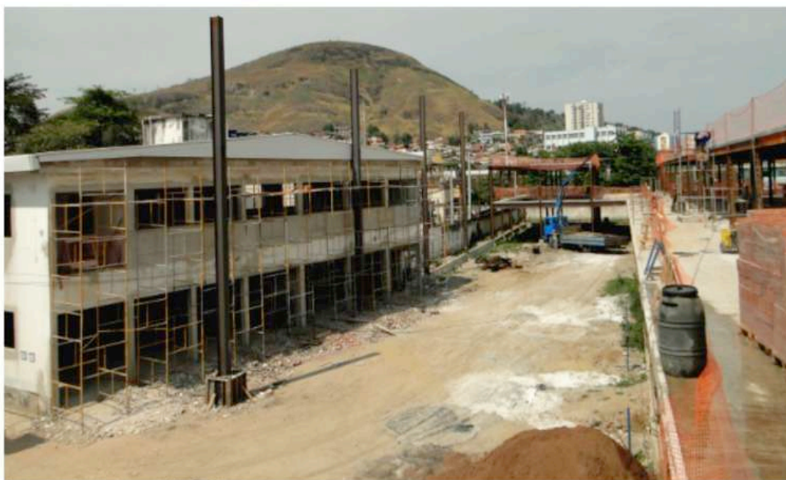
Obras serão finalizadas no início de 2015
