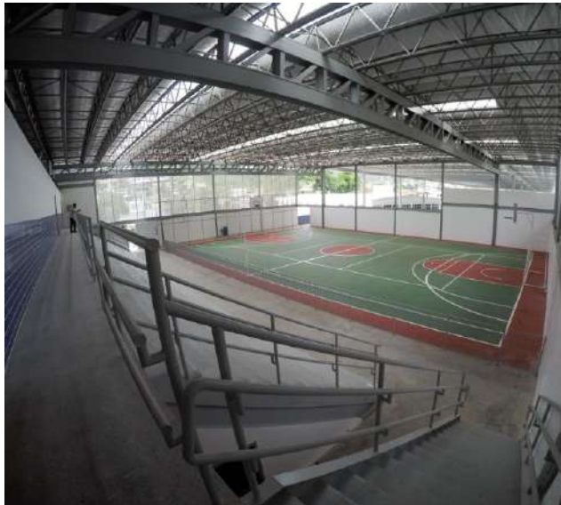
Figura 43F – Quadra de esportes finalizada.
