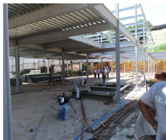
Figura 52 – Início da construção da sede Caxias (CPII, 2012).
