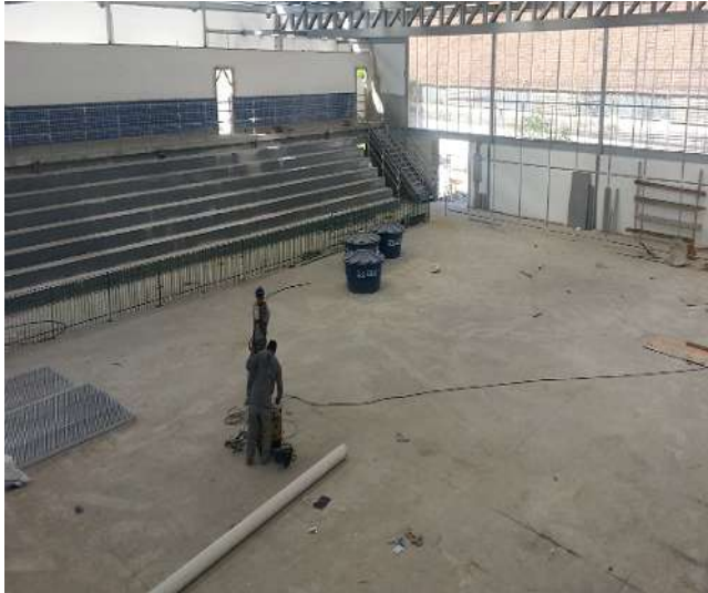
Figura 43D – Construção da quadra de esportes. Foto de julho de 2015.
