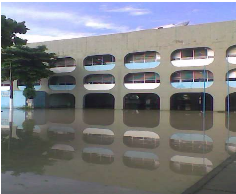
Figura 38 – Foto demonstra o CIEP alagado. Foto disponível em: https://mapio.net/pic/p-13160473/ . Acesso em: 06 dez. 2020.
