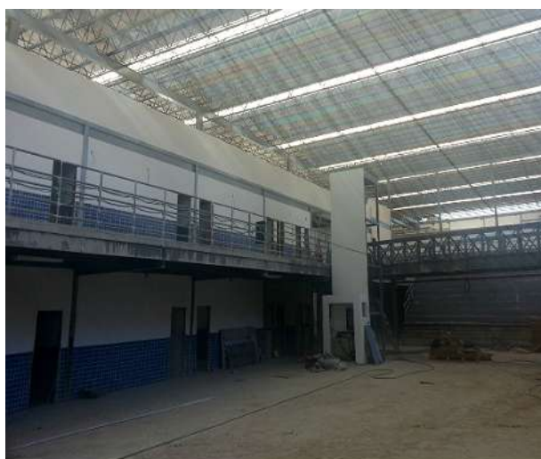
Figura 43B – Pátio interno do Campus Niterói em construção. Foto de julho de 2015.
