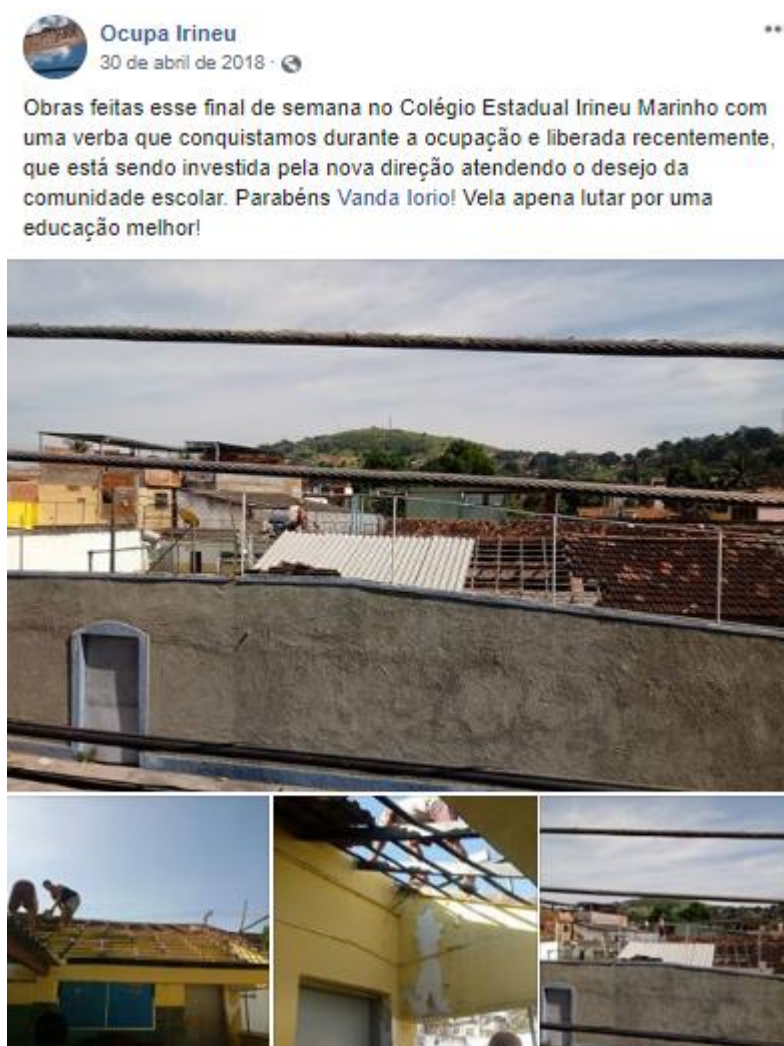
Figura 40- Obras no C.E Irineu Marinho
