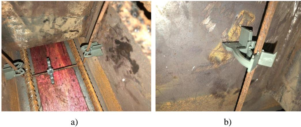
**Figura 4.10 - Detalhe dos espaçadores utilizados: a) Espaçadores na vertical e na horizontal; b) Modo de fixação dos espaçadores.**
