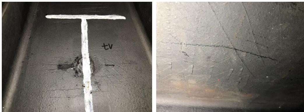
**Figura 6.36 - Plastificação das almas dos perfis de aço do pilar PM-2.**
