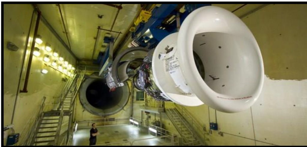
Figura 8: Célula de teste de um Banco de Provas com bellmouth instalado.
