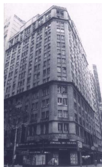
F45 Gusmão, Dourado e Baldassini Ltda, Edifício Guinle, Avenida Rio Branco, 135, c. 1928
